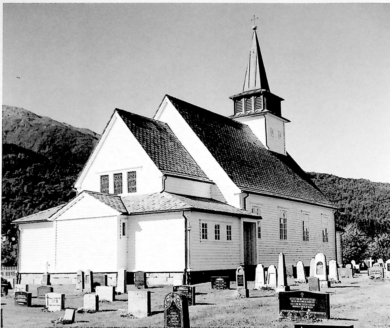
Uskedalen kapell etter ombyggingen. Foto H.E.L.
