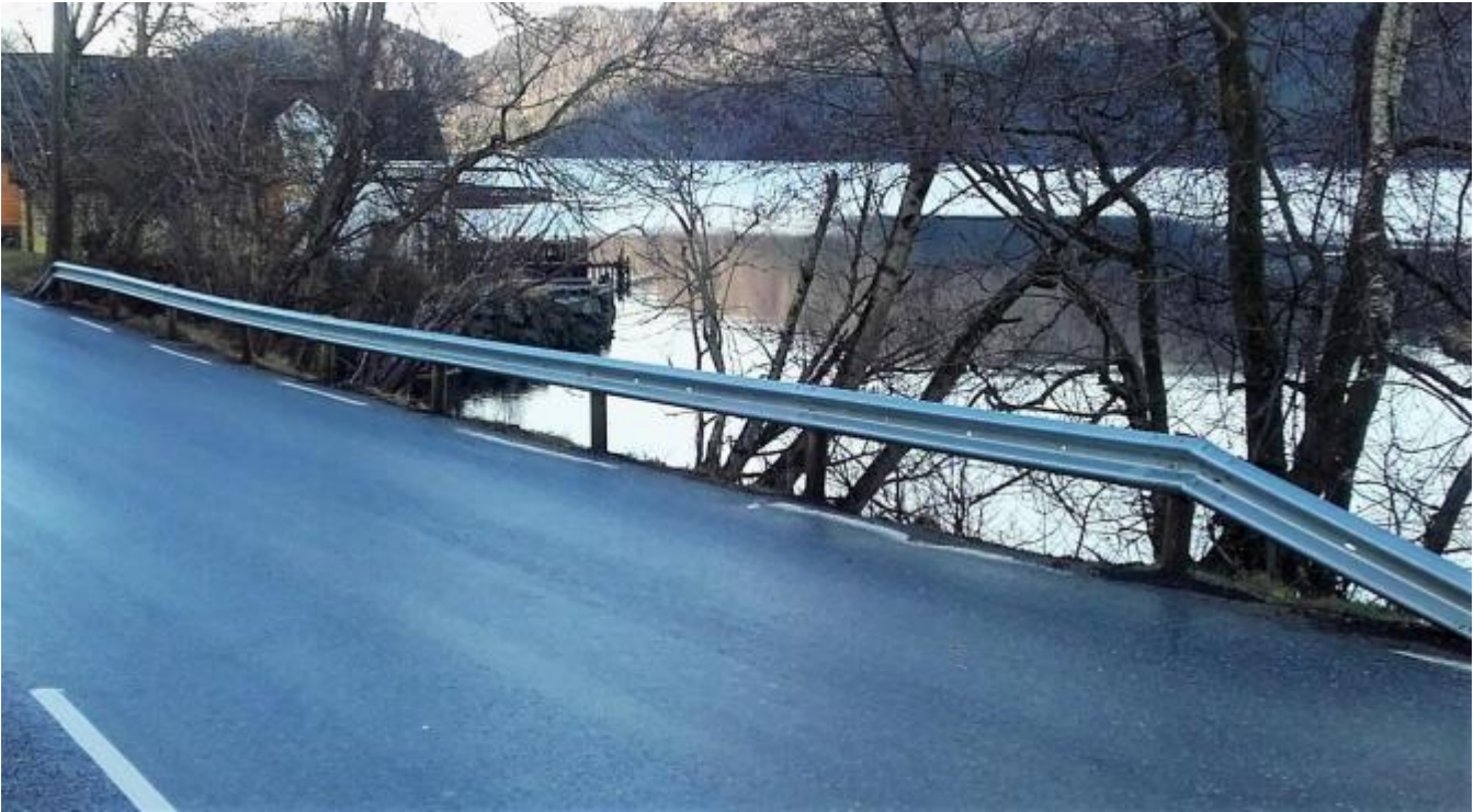
Vegen ved elvosen på Nedre Fet er sikra med nytt rekkverk etter utforkøyning.
