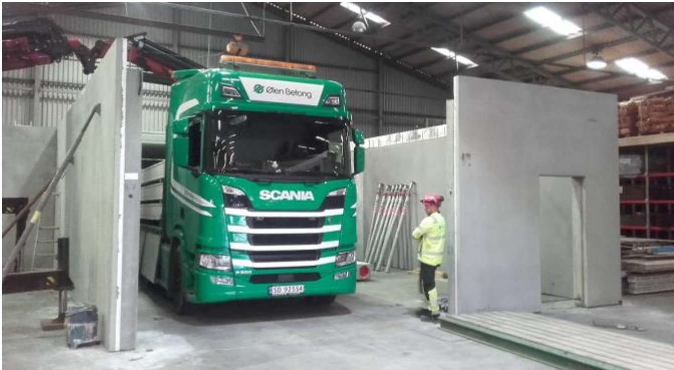
All trevare- og betongproduksjon vert flytta til eigna lokale på Beinavikjo.
