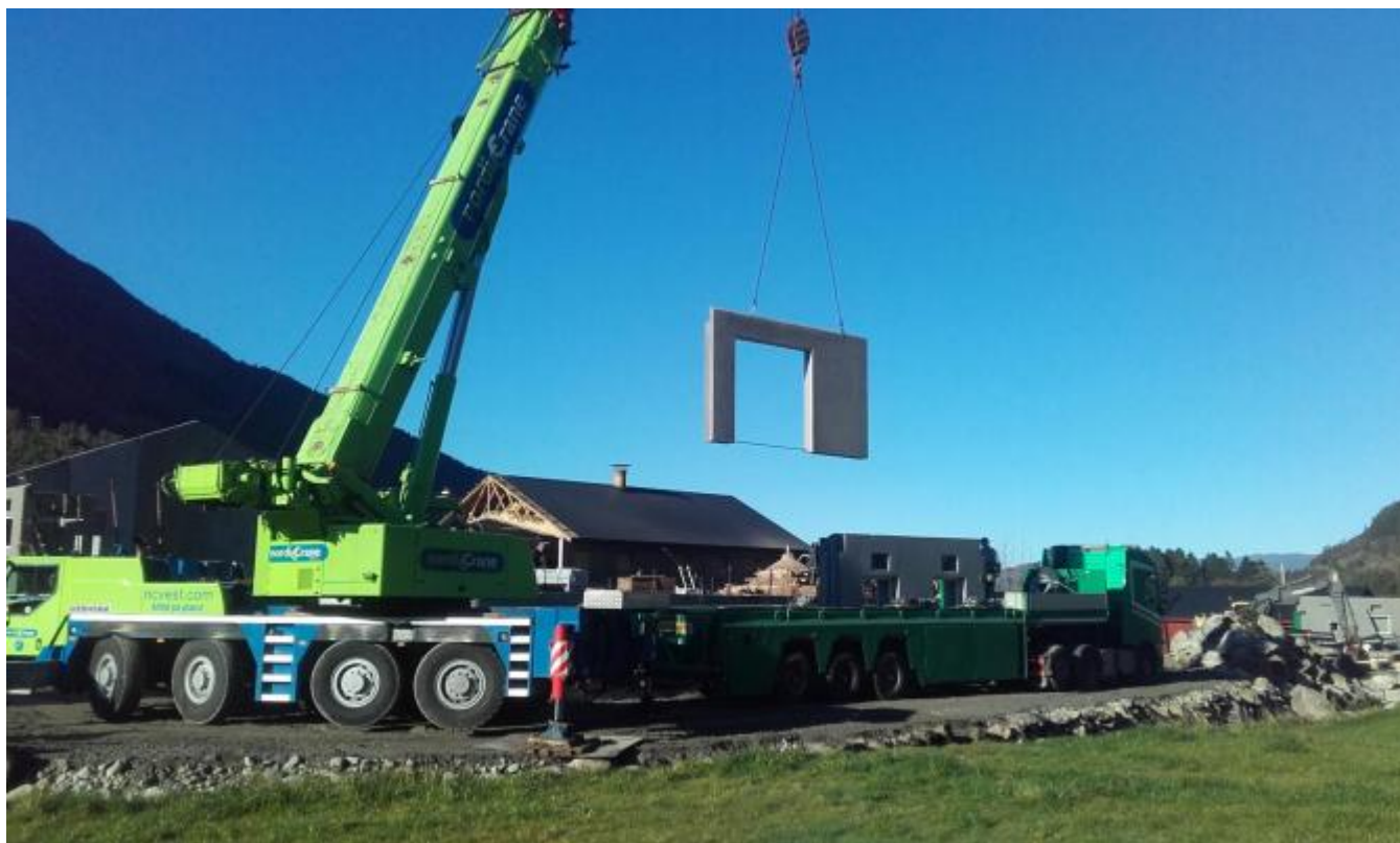
Kranbil frå Nordic Crane med ei løfteevne på 150 tonn er på plassen.
