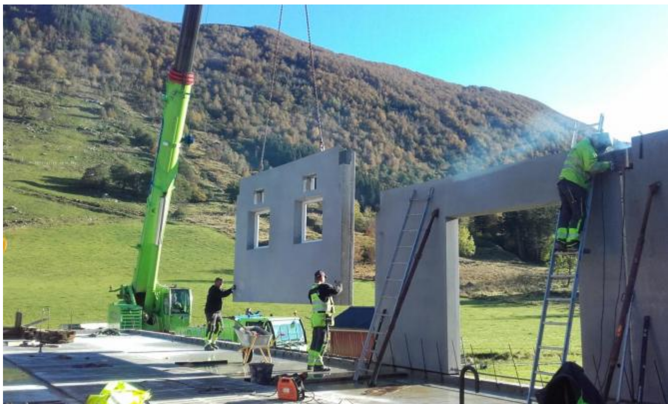
40 element går med til ferdig bygg på Haugland.
