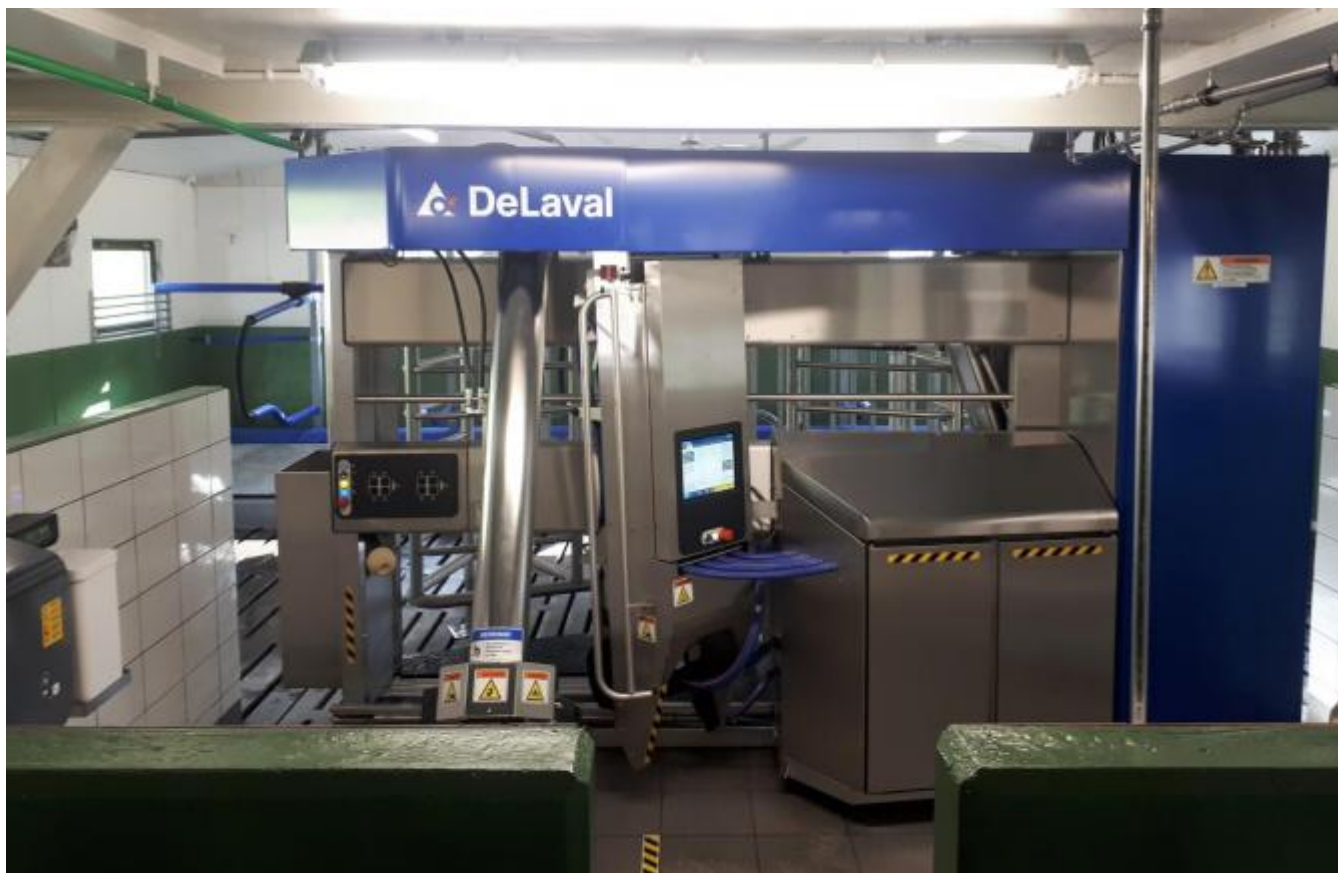
Roboten - den nye tekniske installasjonen i ein fjøs.
