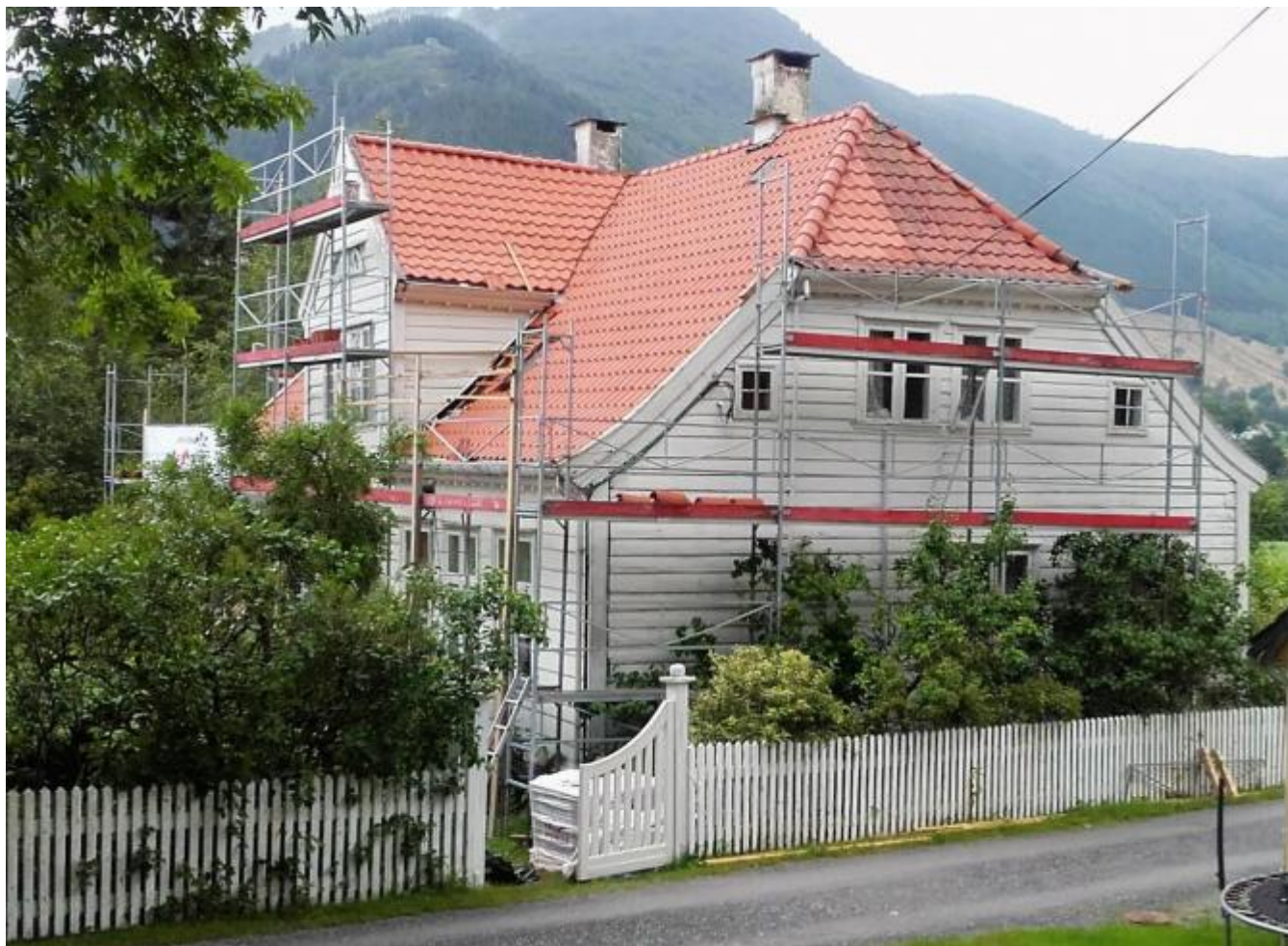
Kapteinsgarden frå 1776, bygd i bergensk empire stil, er i privat eige. Huset er vedtaksfreda.
