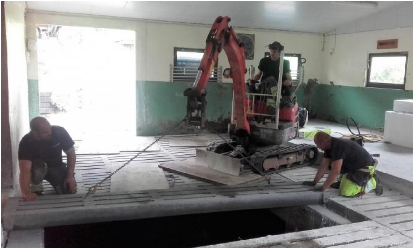
Bilete syner arbeidet med legging av nytt splateplan.
