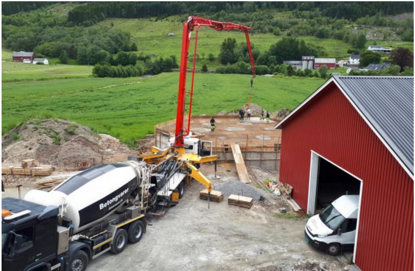
Alt betongarbeidet med ny flor og gjødselskjellar på Leite er gjort av Nesvik Landbruksbygg.
