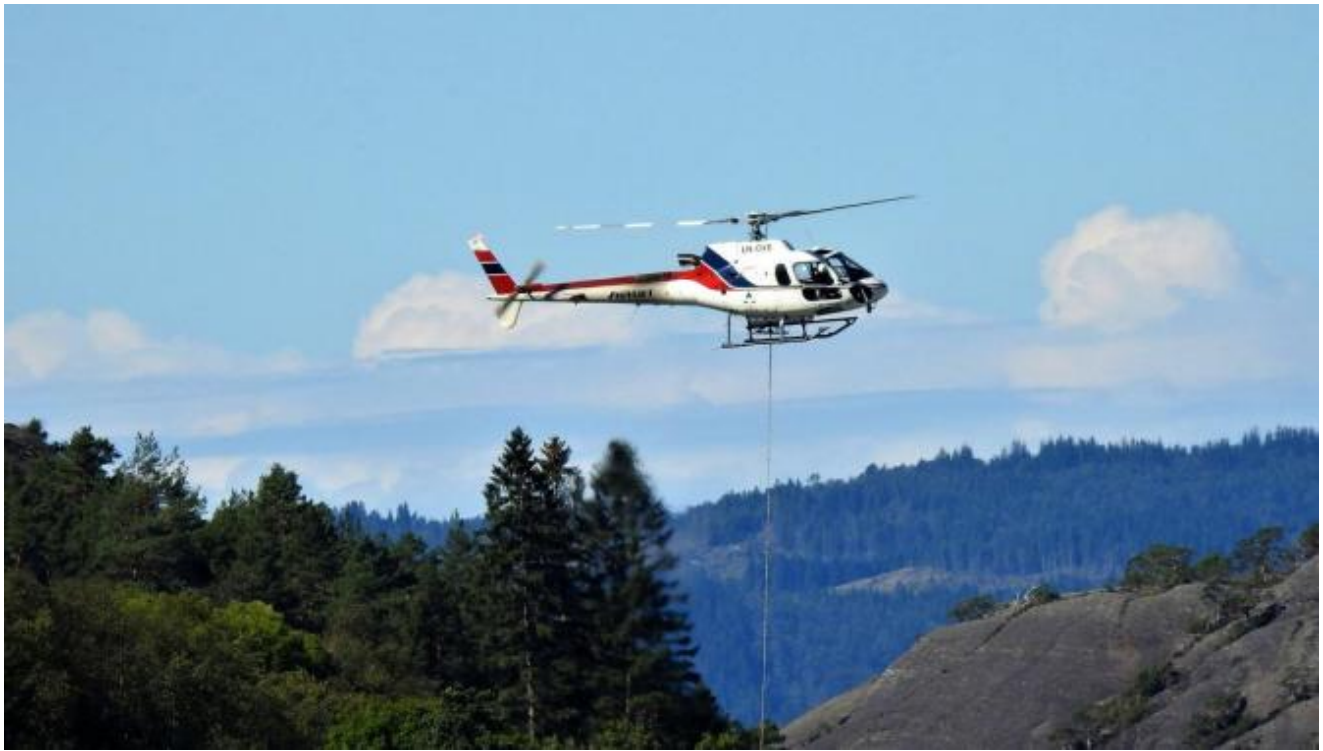
Transport av stolpar fram til plassen mellom Øredalen og Oskar Langballe sitt tun.
