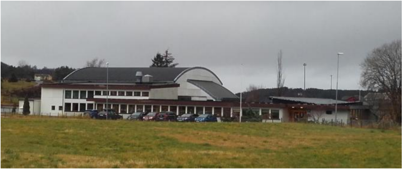
Uskedal skule er over fleire år renovert. Det siste er nye elevtoalett.
