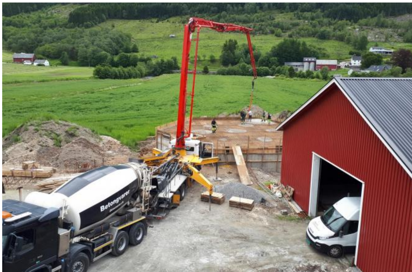
Bilete syner arbeidet med ny gjødselkum i juni månad. Nesvik Landbruksbygg har gjort arbeidet med forskaling og betong.
