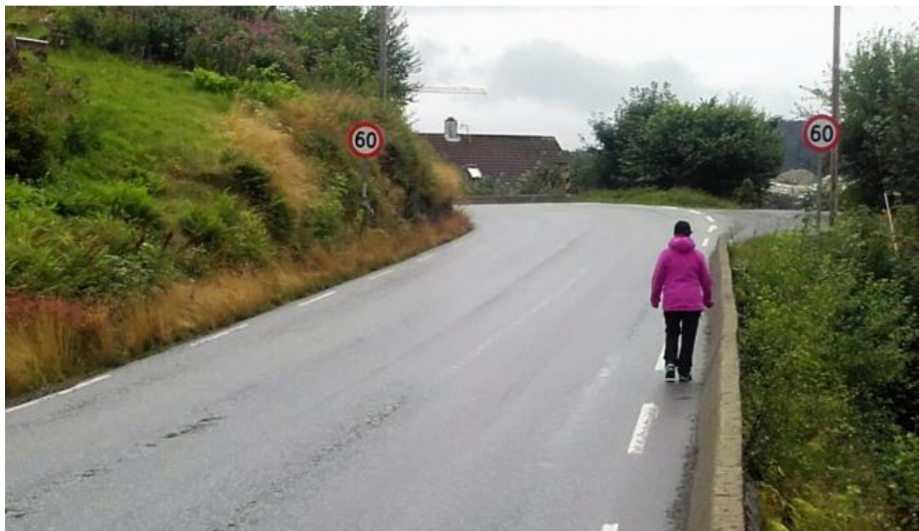
Buasvingen er eit kritisk punkt. Farten er 60 km/t. Gåande på ut må over på feil side av vegen. Ein låg murkant er ei falsk sikring frå eit stup på fire meter.
