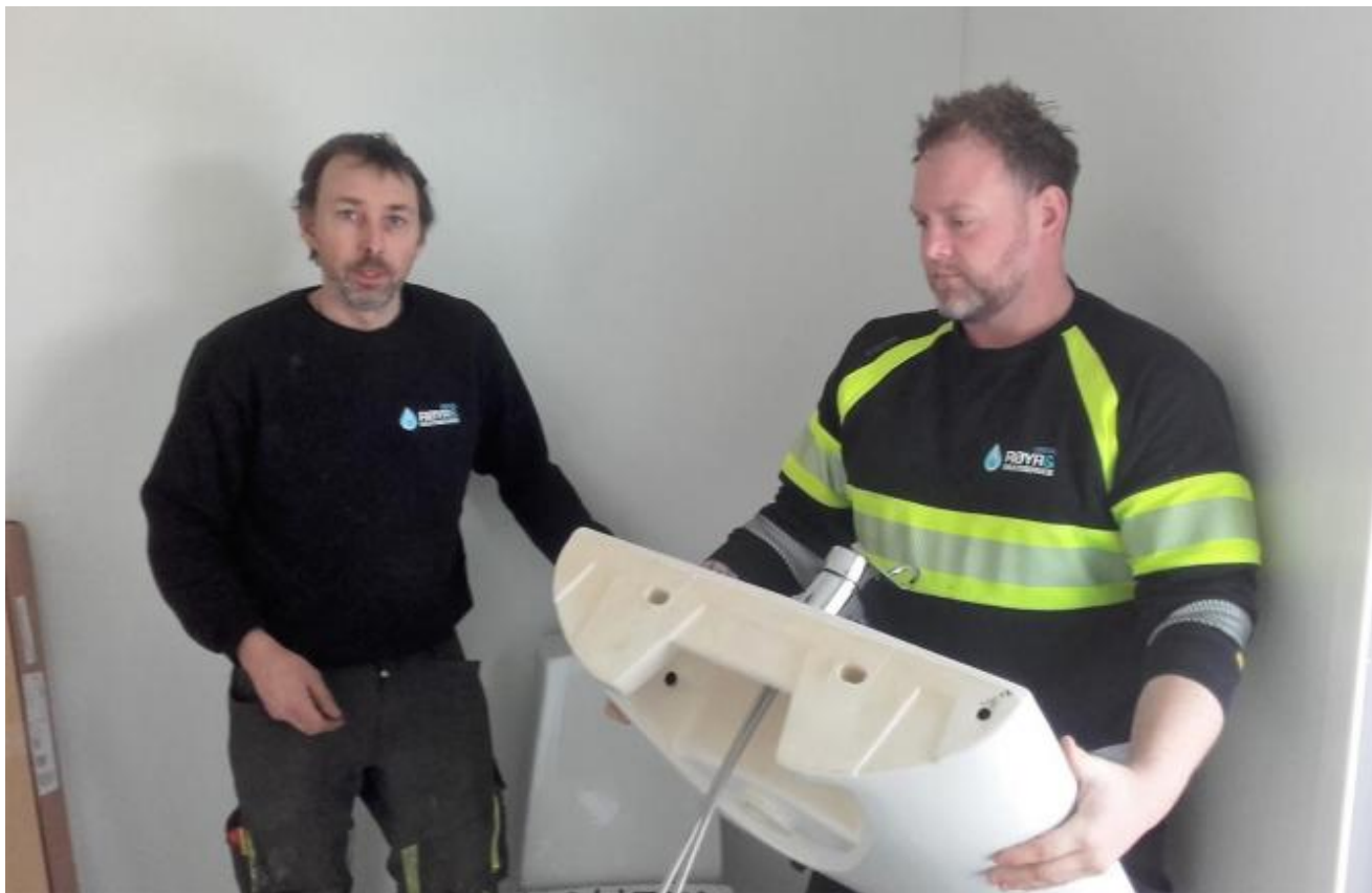
Ronny Kroka og Geir Vimme hadde arbeidet med ferdigstilling av handikaptaoiletet i Gamleskolen.
