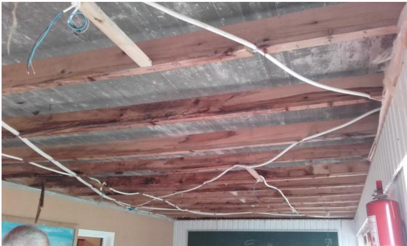
Takpanel og isolasjon vart fjerna, mellom anna for å finna årsaka til fuktskadene.
