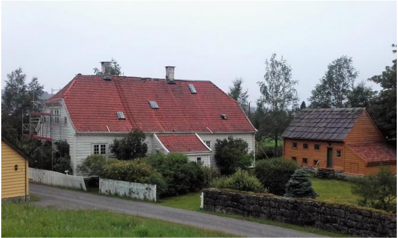
Taket på sørsida er i tolleg god stand, bortsett frå kjølen og lekkasje ved nokre takvindaugo.
