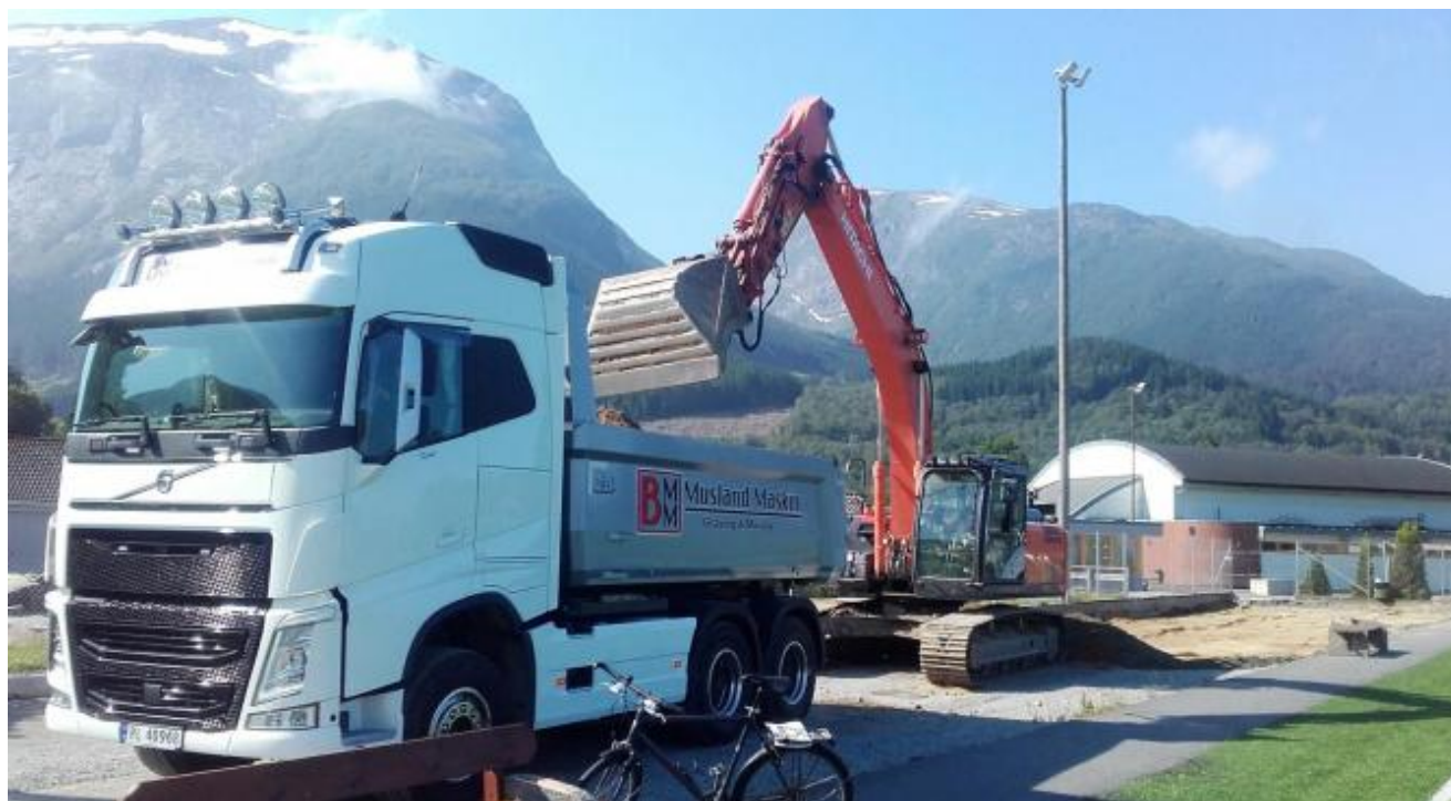
Musland Maskin har jobben med å ta bort, drenera og tilføra nye og betre massar før asfaltering.
