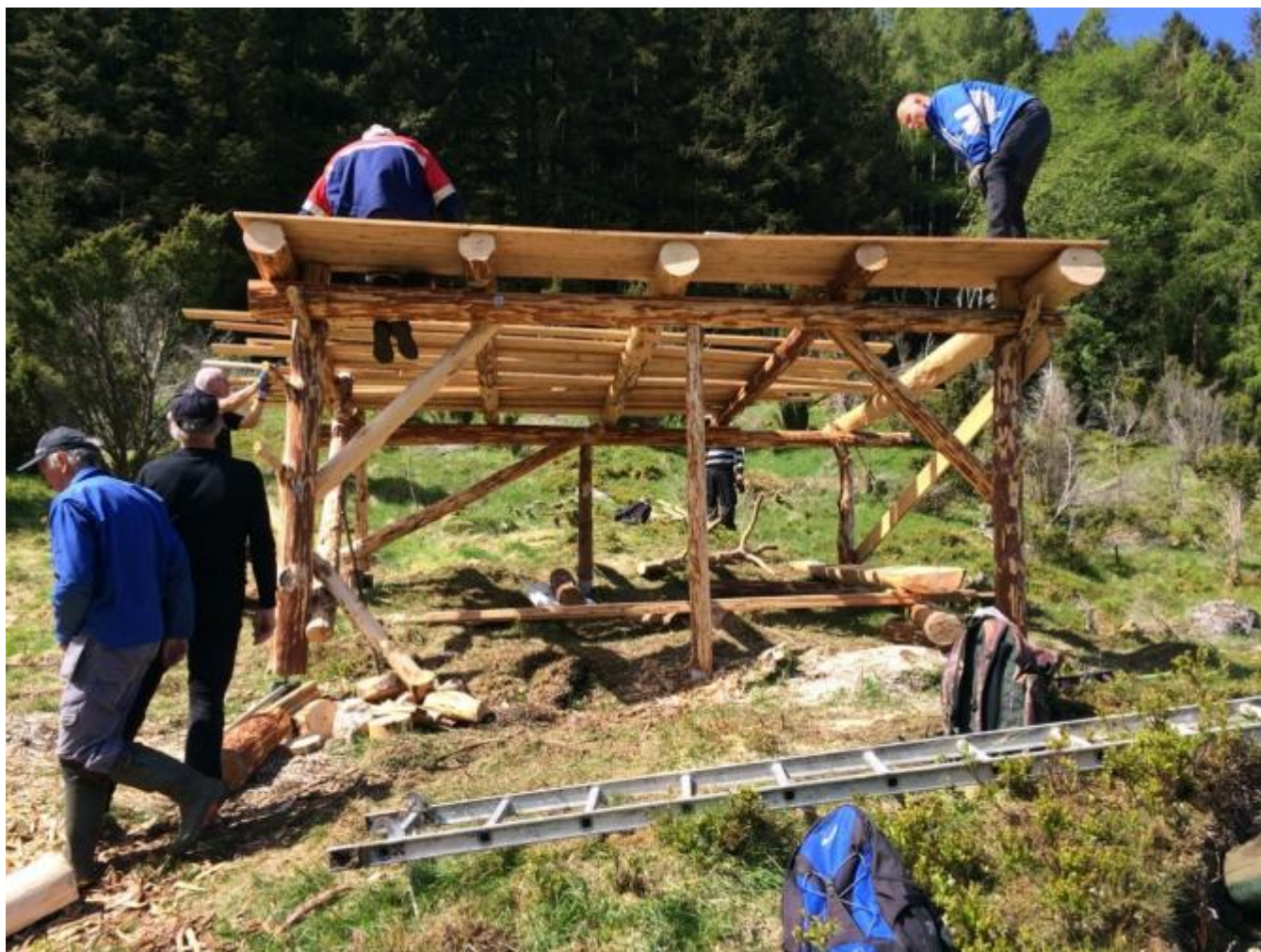
Dugnadsgjengen i arbeid
