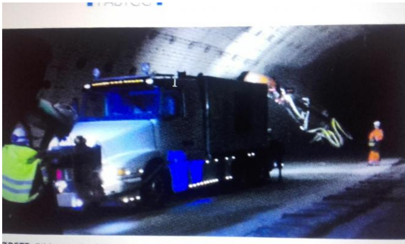
Bilete syner Audun Ljosnes sin bil i arbeid i ein tunnel.
