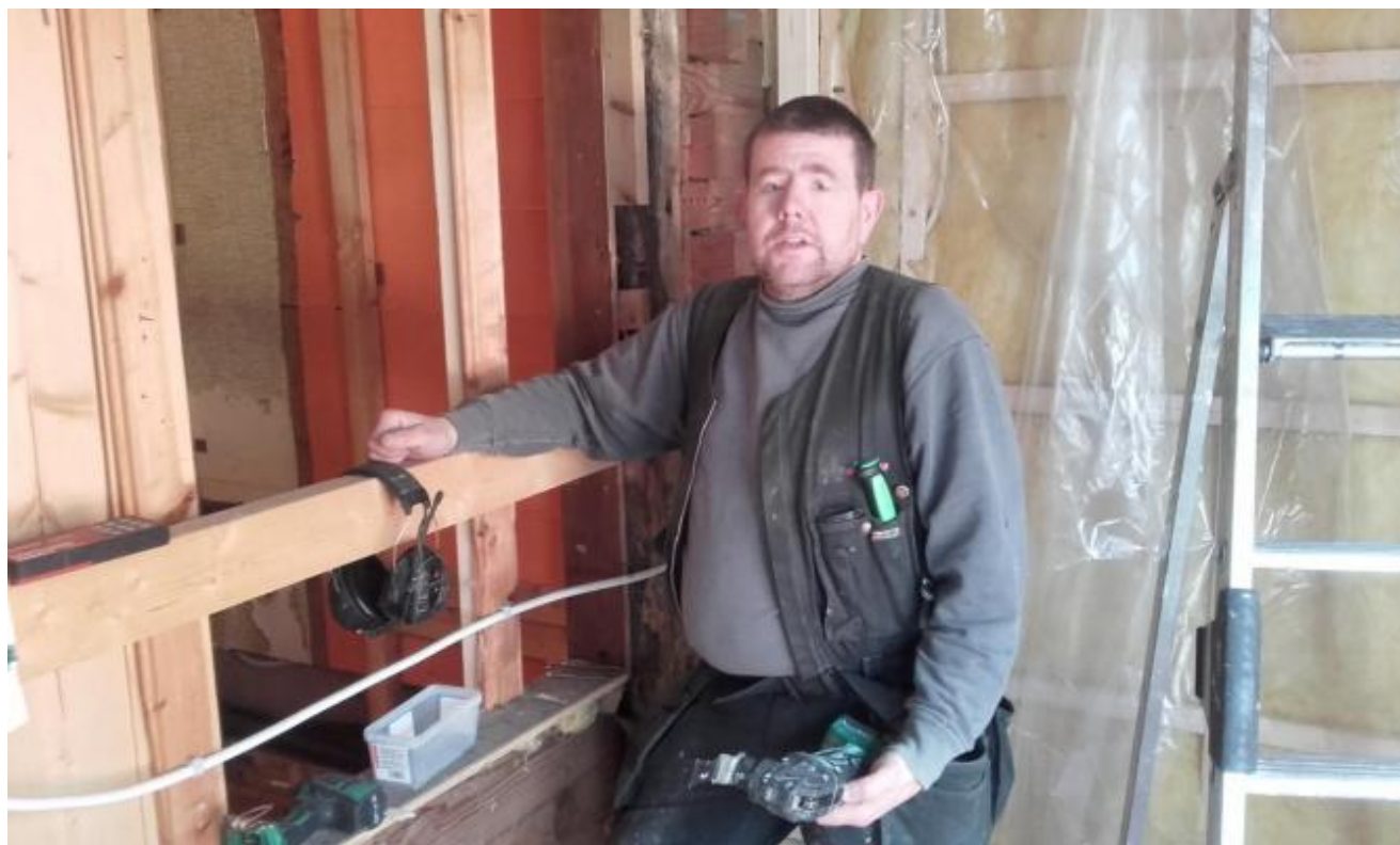
Rune Volden frå Kvinnherad Bygg er snikkar og gjer det meste av arbeidet med renovering og montering av nytt handikoptoalett.
