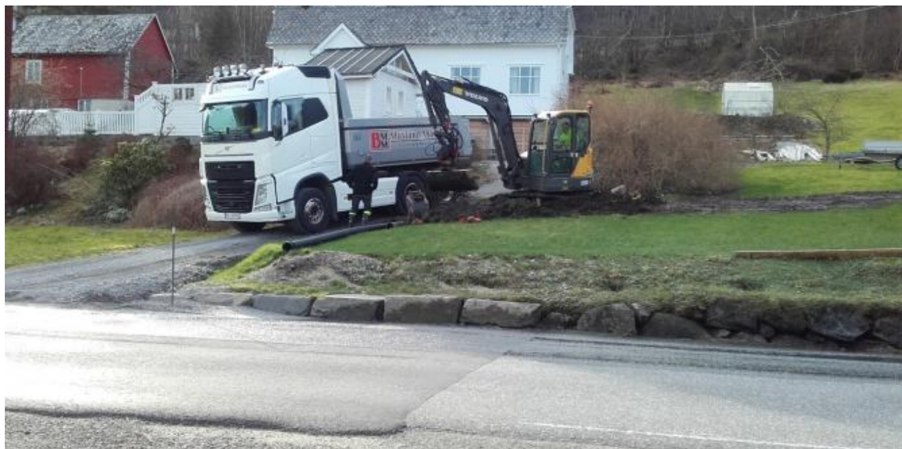
Musland Maskin var i denne veka i arbeid med å utbetra tett kistegrøft ved Fitjanaustet.
