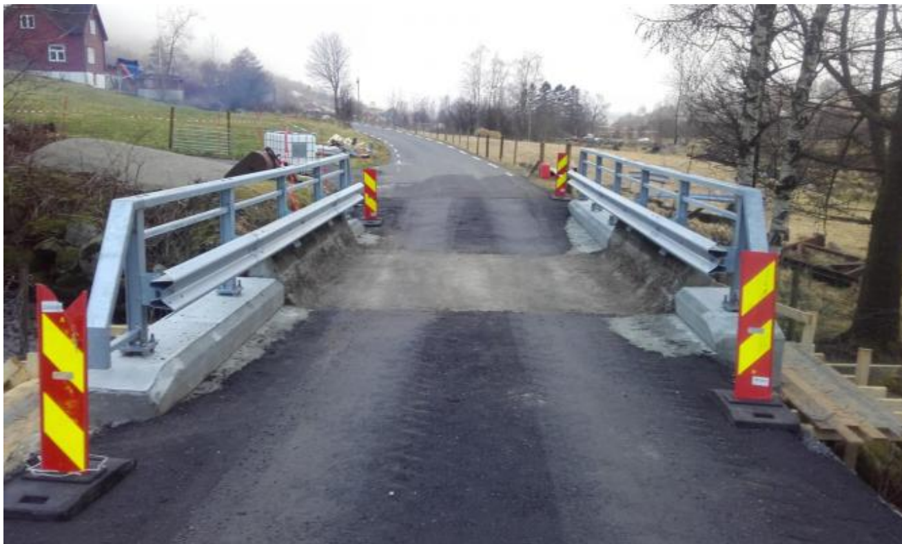
Brubekkebrua på Døsmland er opna for trafikk, men ein må vera merksam på eit søkk på sjølve brua.
