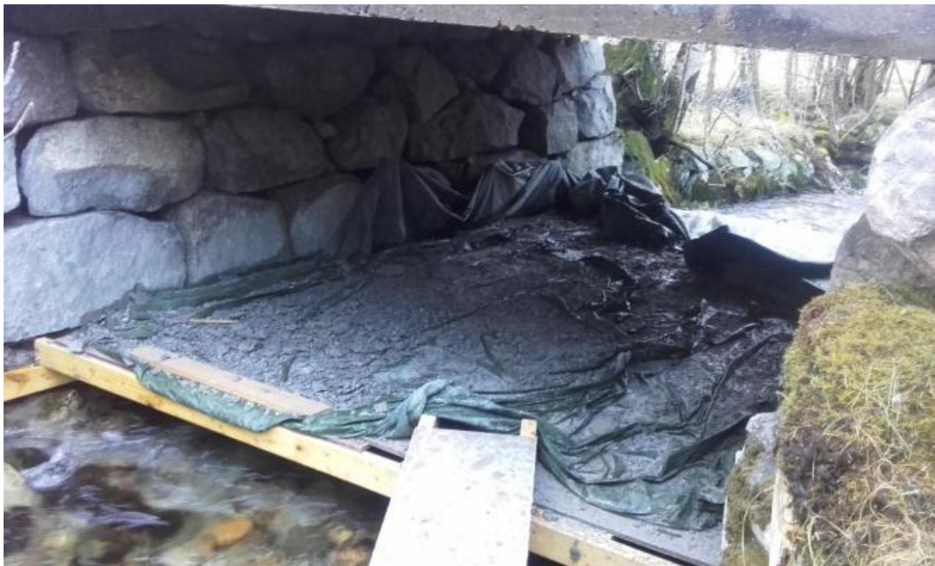
Det vert reingjort og lagt ny betong på Brubekkebrua under.
