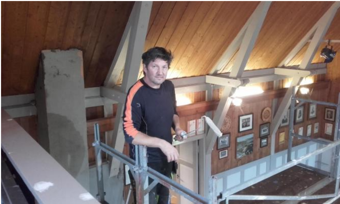
Bård Blom frå Sandvoll Entreprenør er målarmeister og står for sjøve arbeidet.
