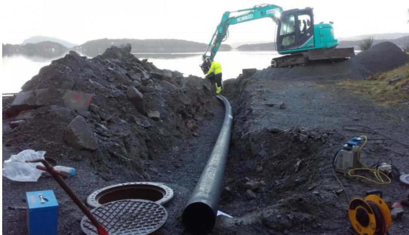
Det vert lagt røyr som skal ta overløpet dersom noko går gale.
