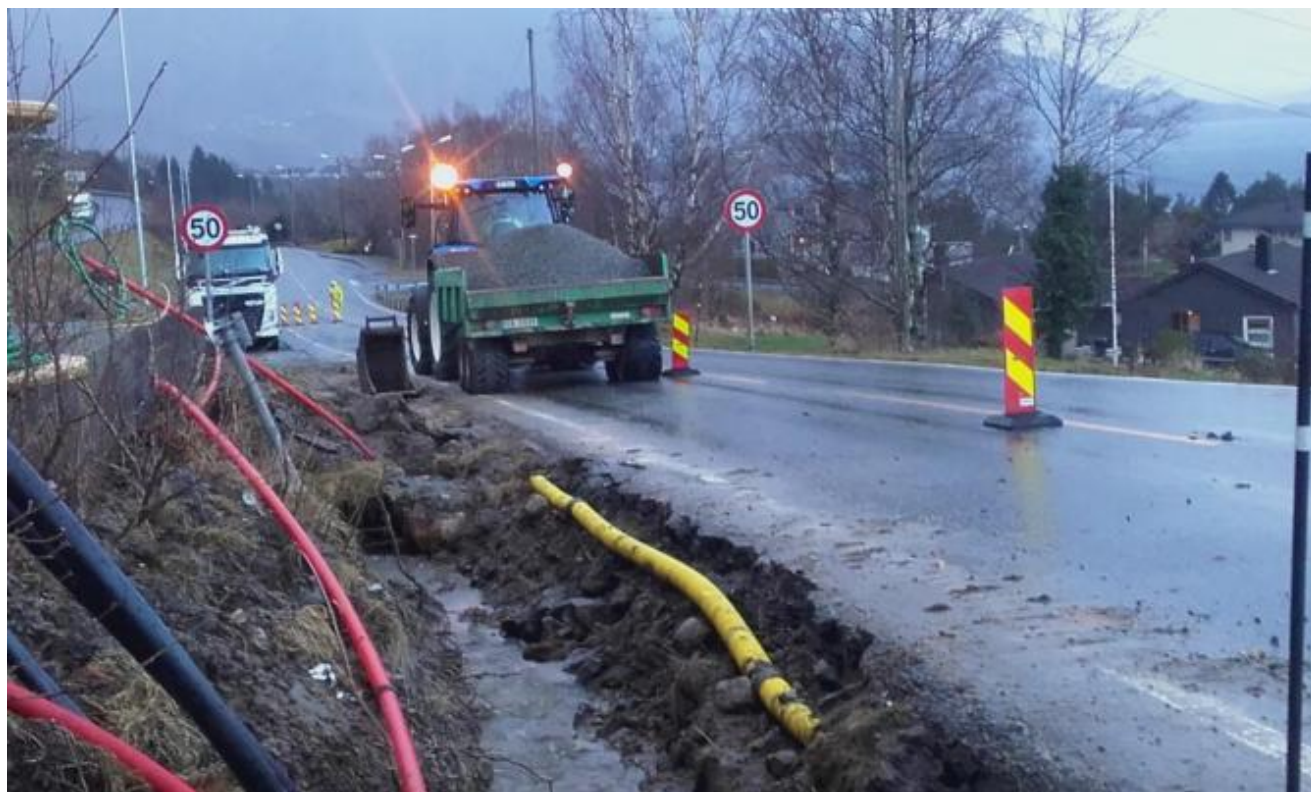
Leganger Maskin er leigd inn for arbeidet med grunnarbeid og kabelgrøfter
