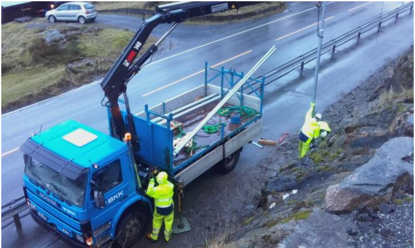
BKK monterer veglys, tilsaman 7 punkt i ei lengde på 350 meter.
