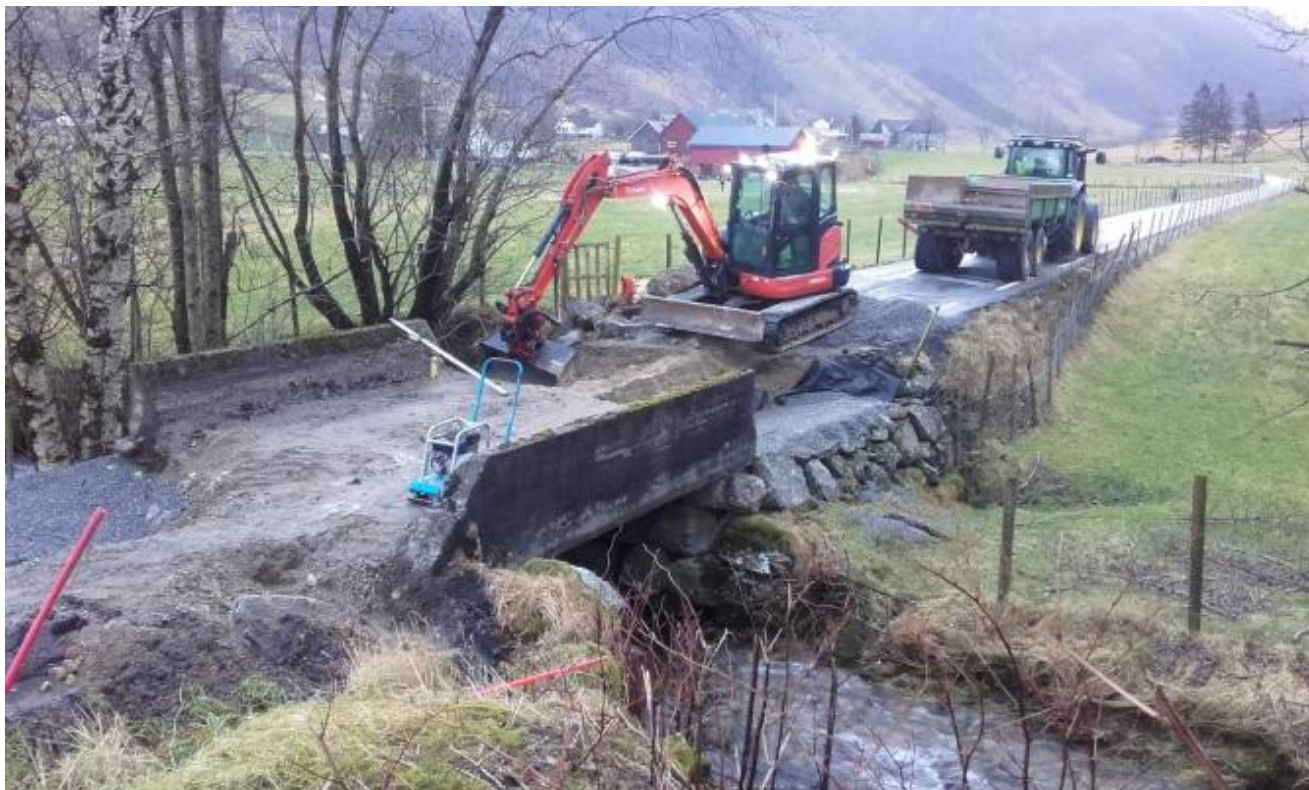
Døsmland bru er stengd så lenge bruvedlikehaldet pågår.
