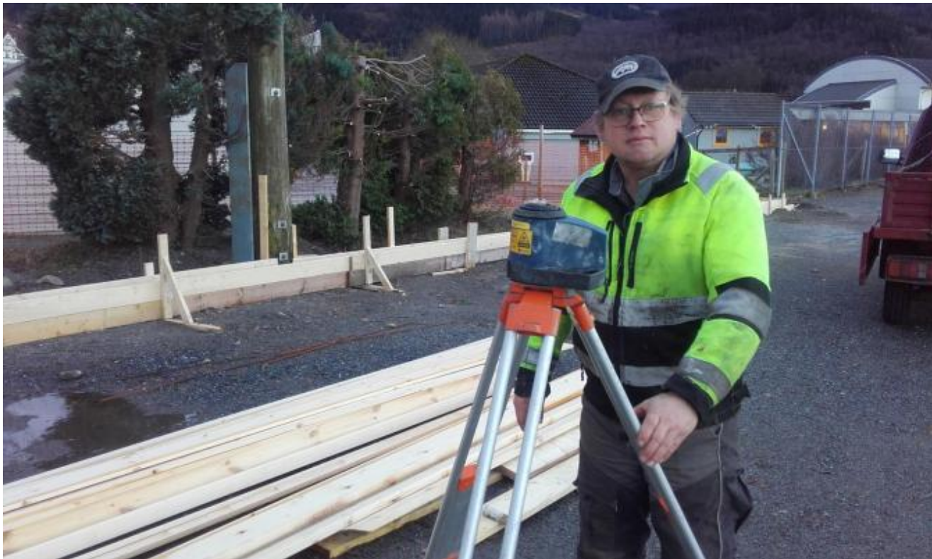
Jone Harkestad har arbeidet med fundamentet og monteringa av nytt gjerde rundt barnehagen.
