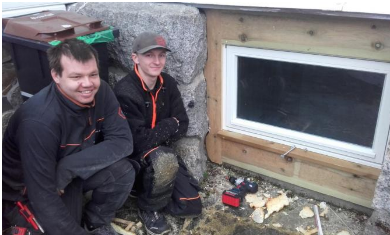
Alle vindaugo i kjellaren er no nye.
