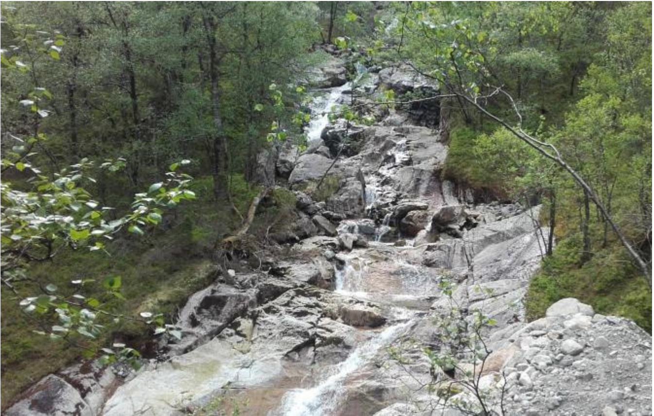
Uskedal Vassverk hentar overflatevatn frå Eikeelva før det vert ført inn i eit vassbehandlingsanlegg på Sørstølen på Eik.
