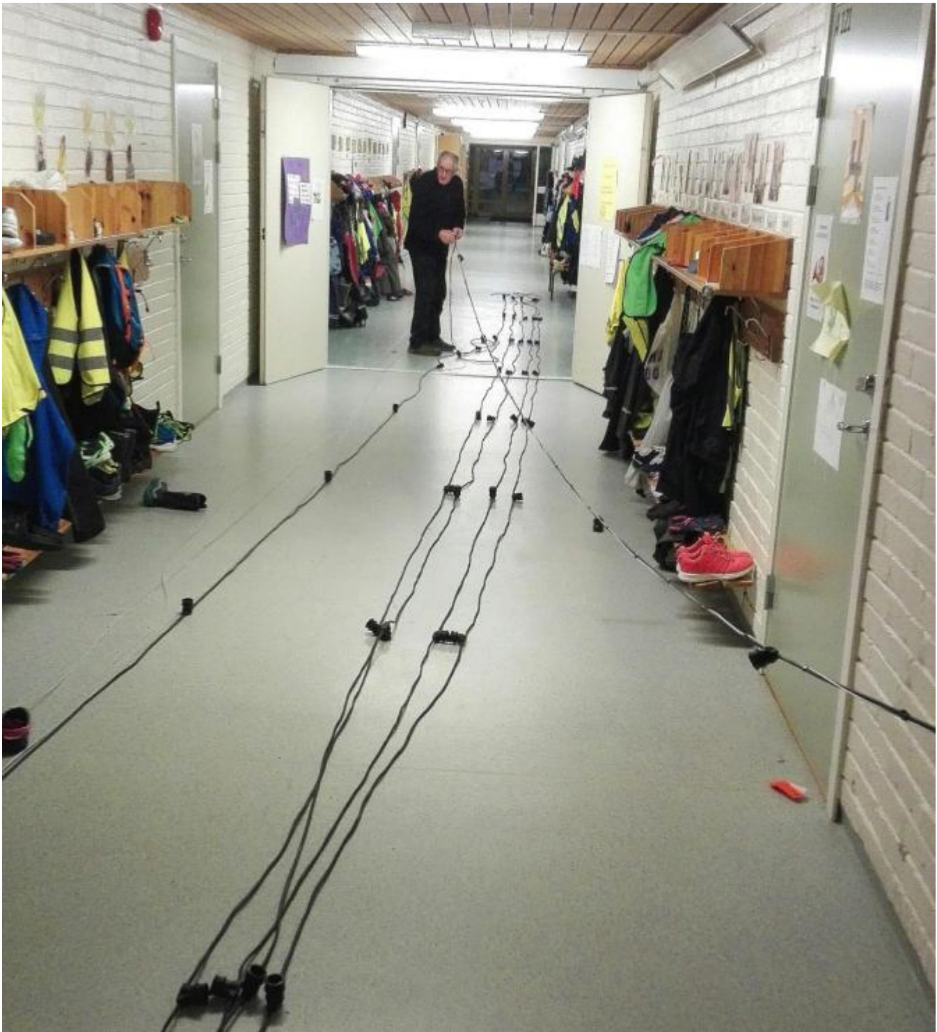
Lekkjene vart strekte ut i gangen, og Svein A. Sunde teipar og stripsa lenkja til vaieren.
