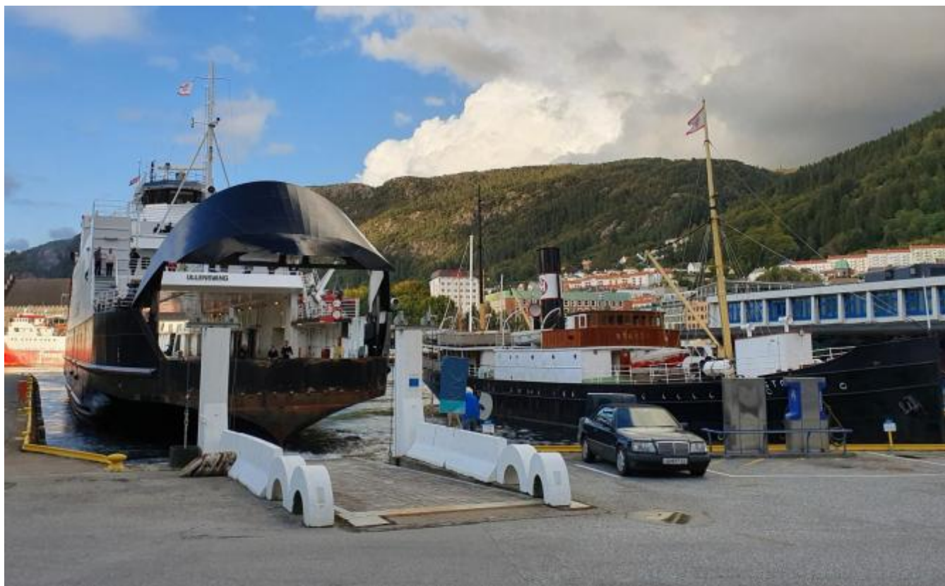
Ved ankomst til Bergen var Harald Sætre i velkomstkomiteen. Den gamle køyrebrua, som vart brukt av MS SUNNHORDLAND, er restaurert og må sveivast for hand
