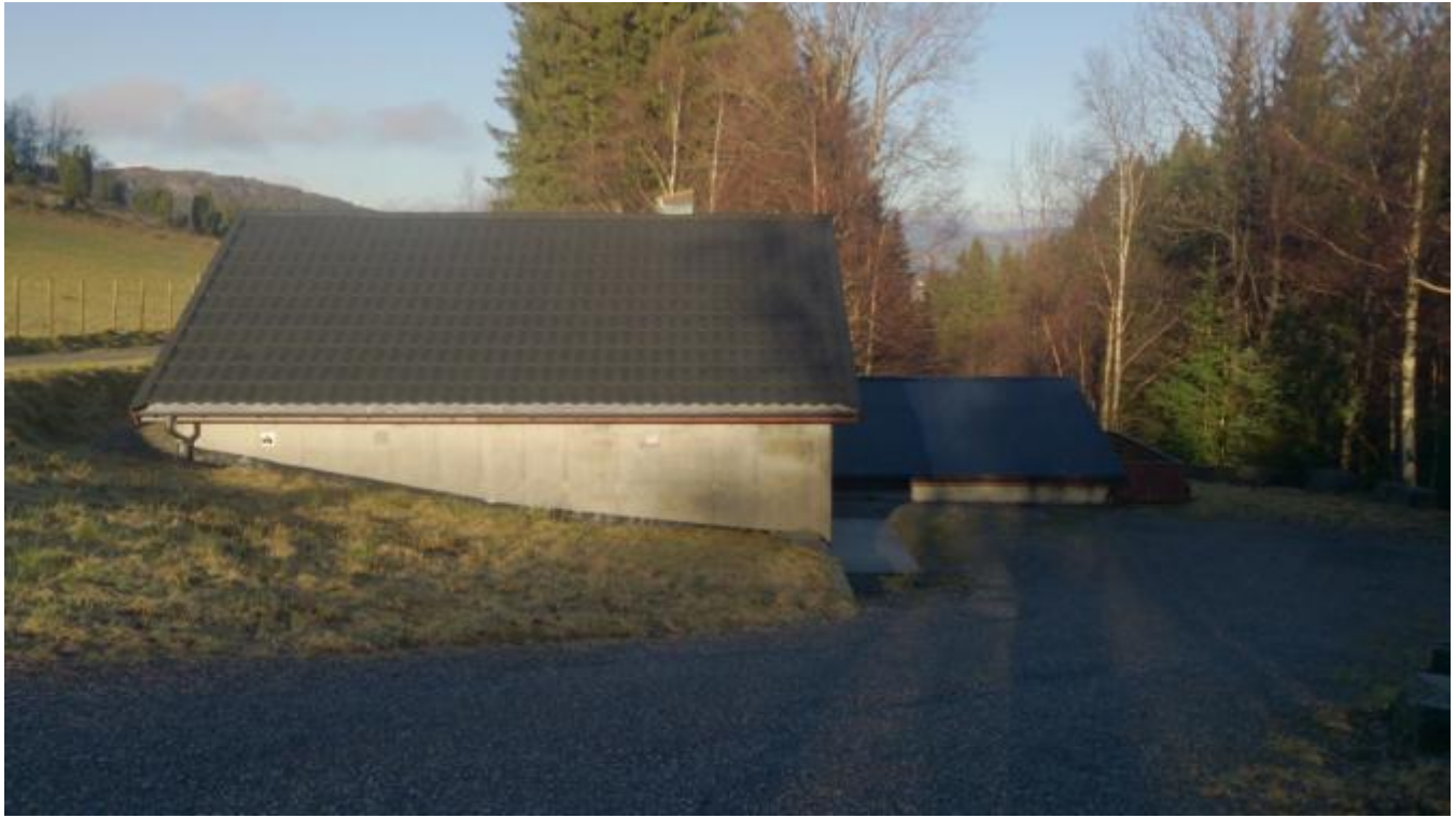
Høgdebassenget og vassbehandlingsanlegget ligg på Sørstølen på Eik.
