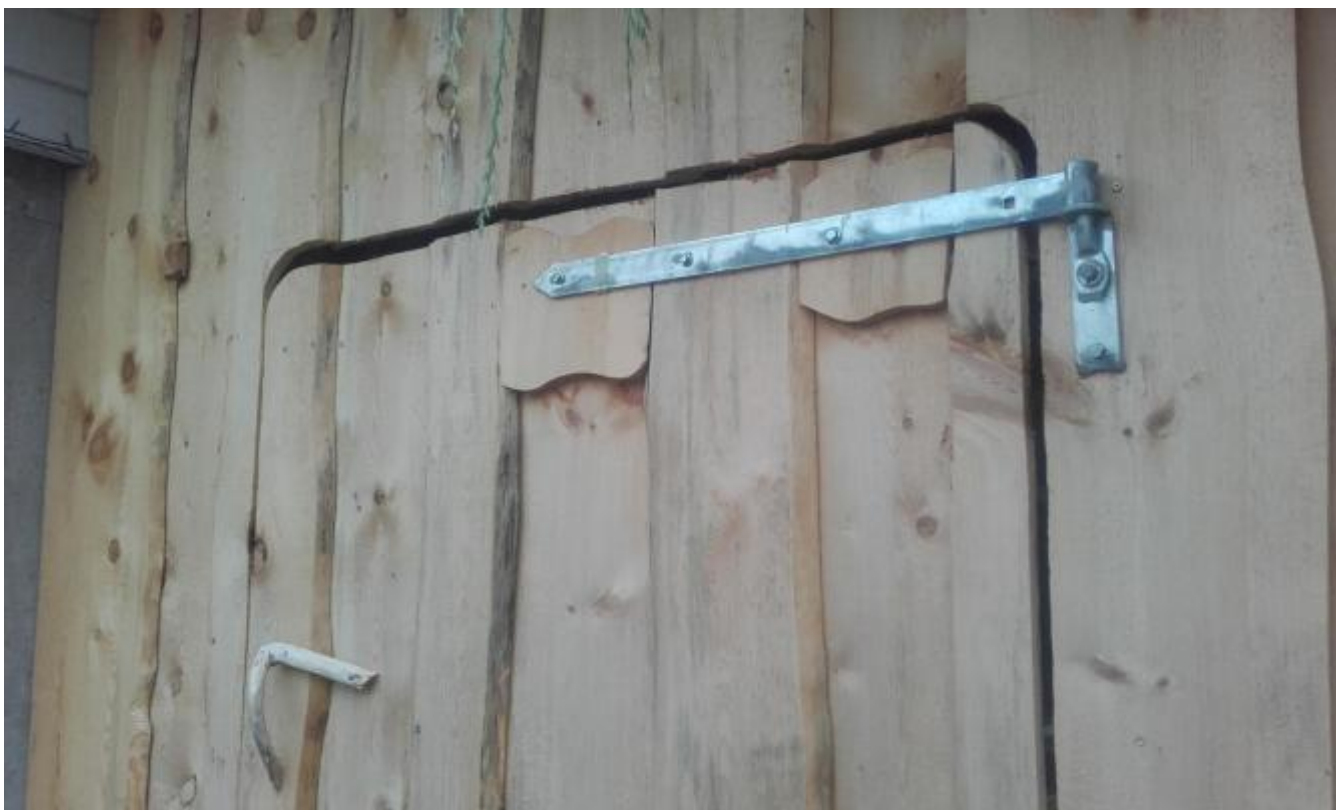
Alle vegger er kledde med ukanta kledning. Døra er skoren til og har mange detaljar.
