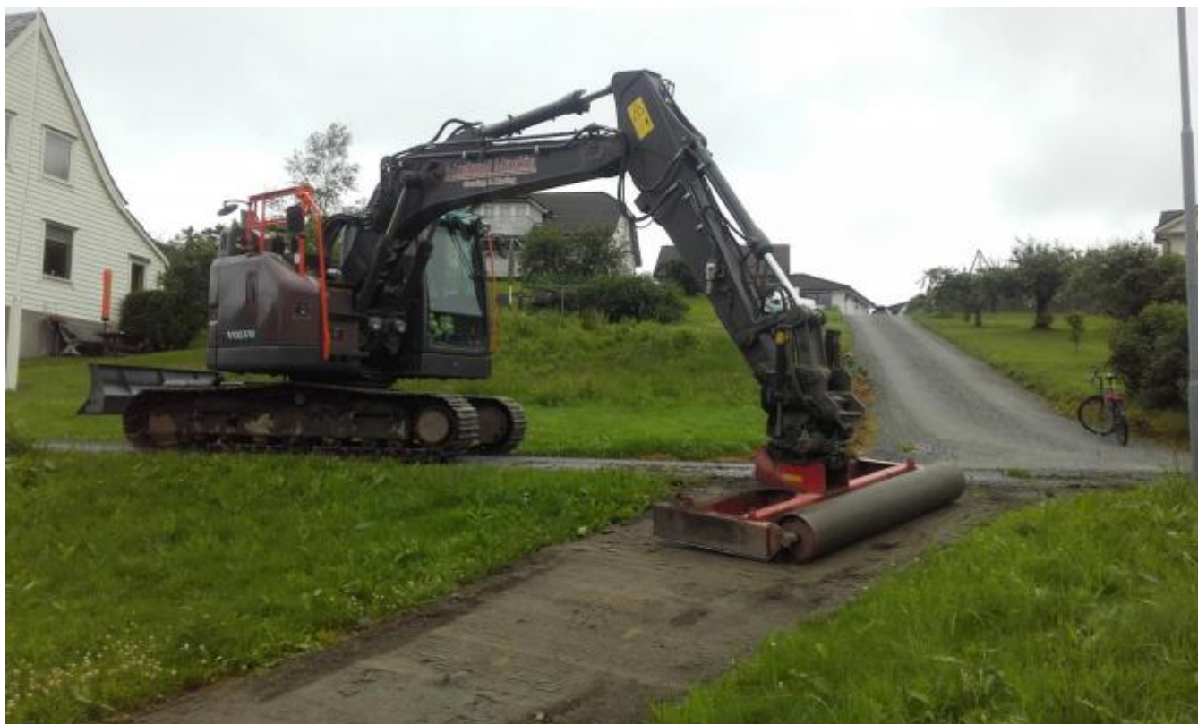
Sidevegane vert reinska, avretta og gjord klar for asfaltering.
