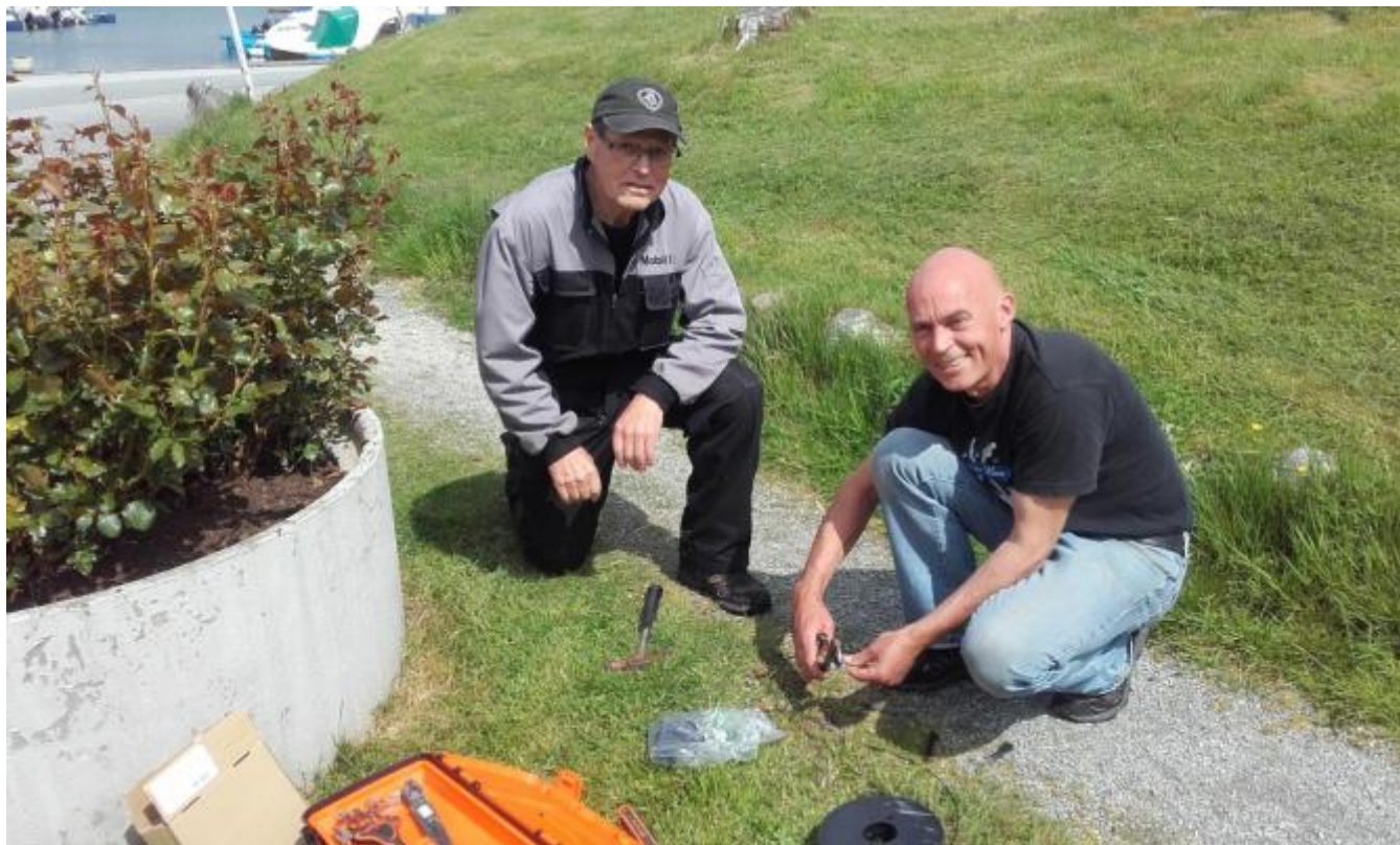
Jan H. Hansen og Daniel Kambestad utfører vedlikeholdsarbeid i Båthamna.
