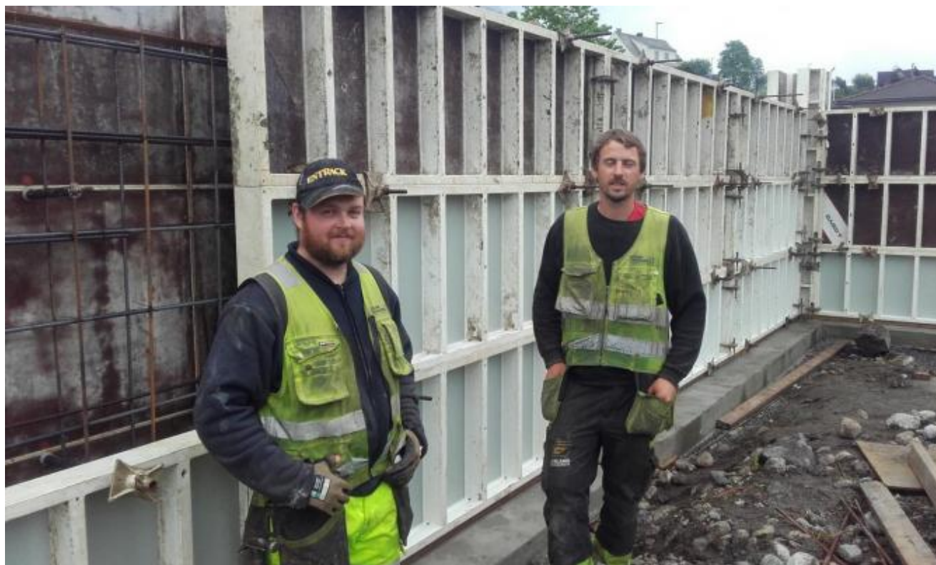
Førstøtningsmuren i eine hjørne på Kunstgrasbanen vert gjort klar for støyping.
