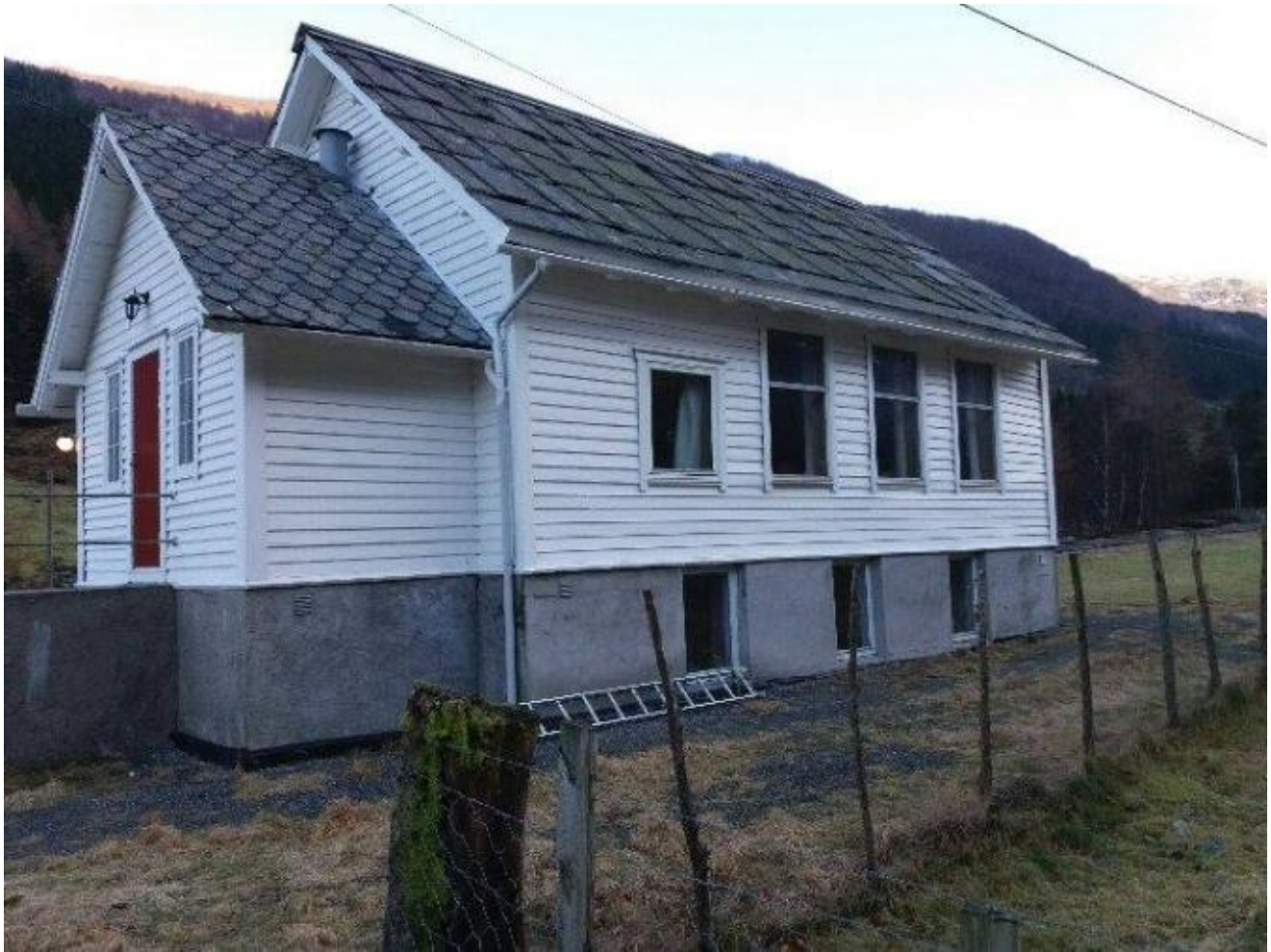
I Vonheim ( tidlegare Helgheim ) vil ein gjenskapa eit lagsmøte slik det var i ungdomslaga på 1930 talet .
