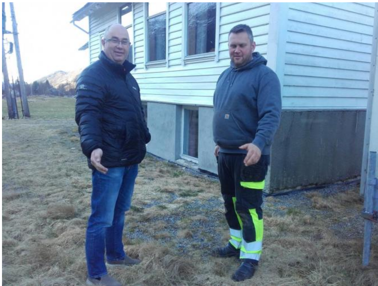
Dette er ein av to aktuelle punkt for boring etter grunnvatn ved Vonheim.
