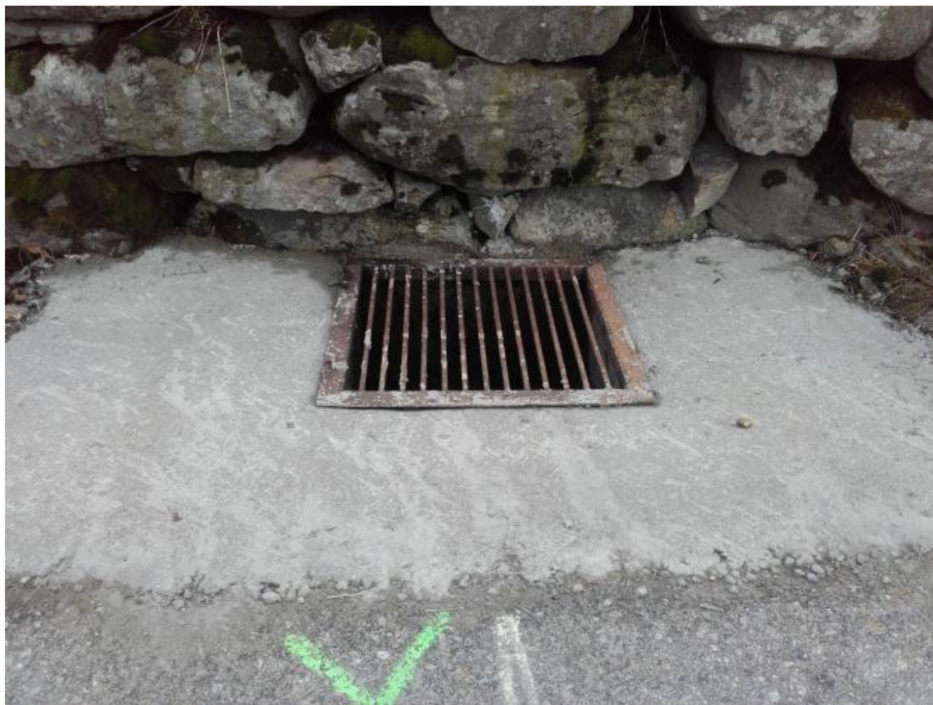
25 kummar er fornya og oppgraderte på Kjærlandssido.
