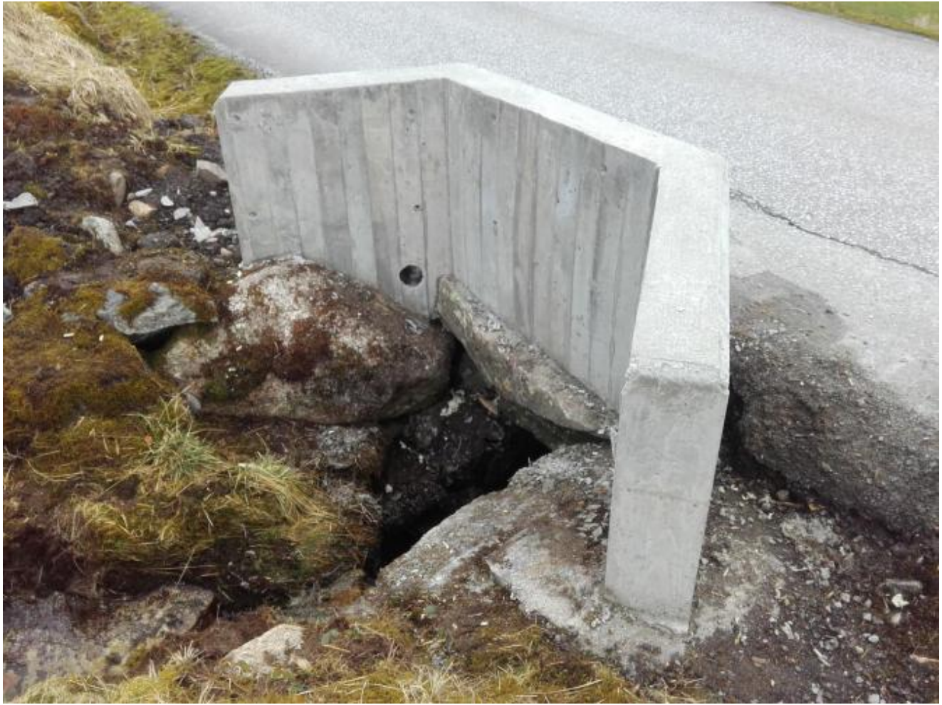
Nokre nedløp er forsterka og sikra med ein forstøtningsmur i bakkant.
