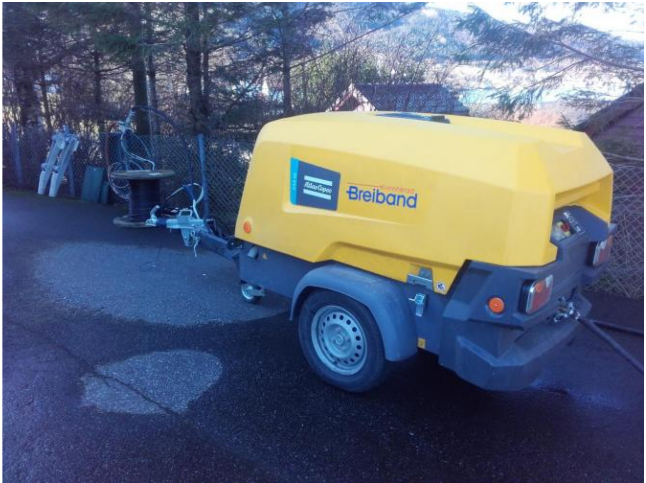
Med kompressor og lufttrykk vert kabelen skoten fram frå nodestasjon ved skulen til stolpe på Neset.
