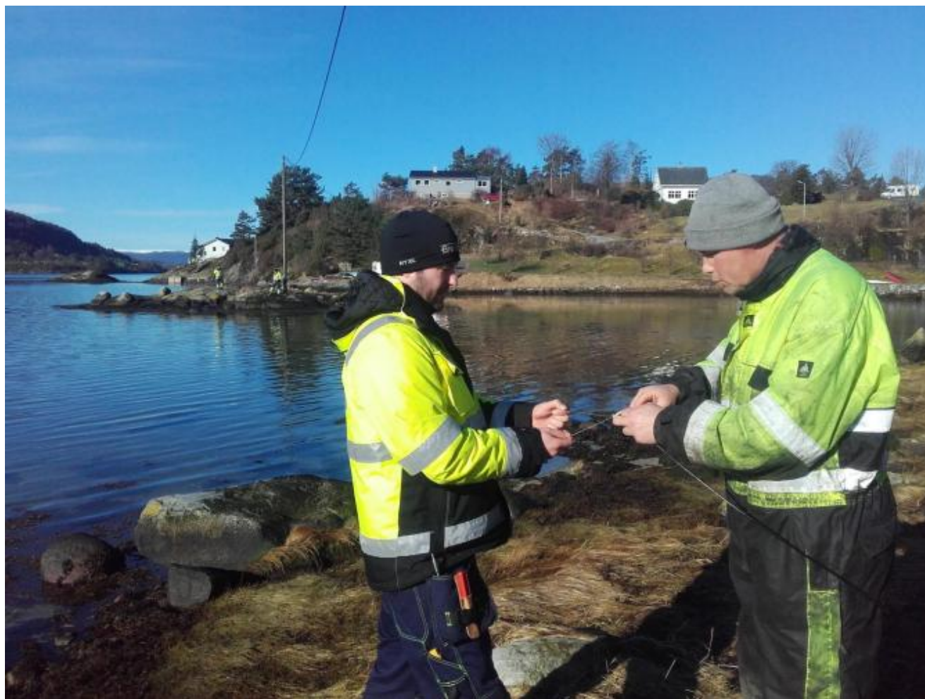
Jan Andre Revheim og Bengt Opsonger gjer klar for kabelstrekk til Holmen.
