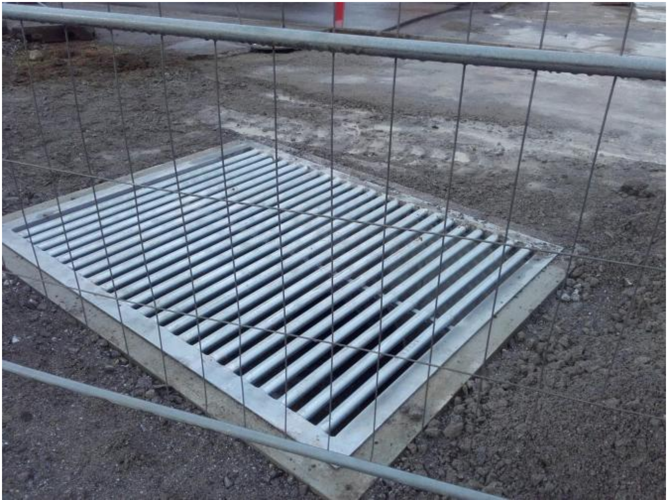
Ein stor samlekuvm på oppsida av vegen er dimensjonert for store vassmengder frå Halsane og lia ovom.
