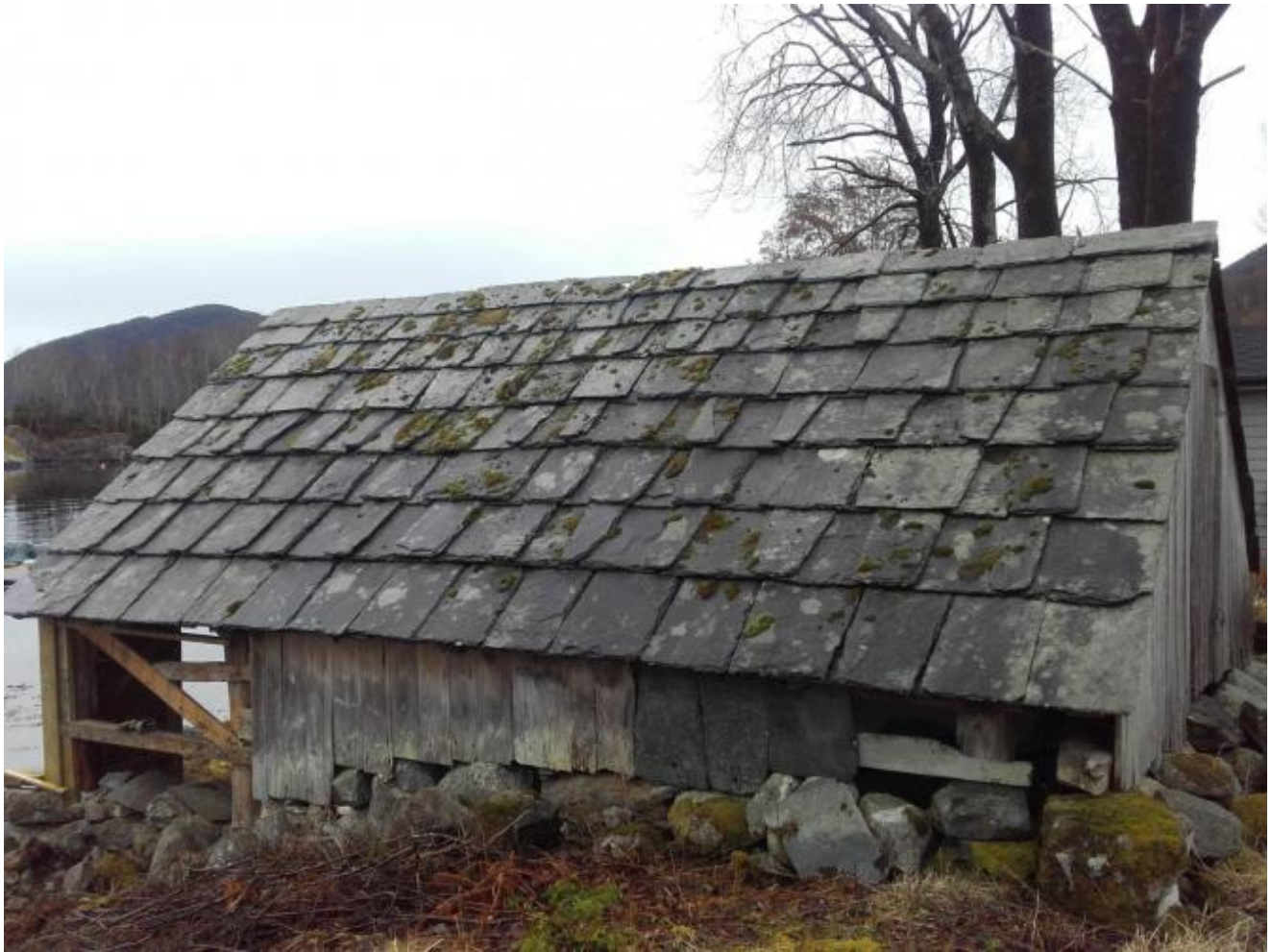
Alle konstruksjonane er forsterka for å kunna tola det gamle helletaket.
