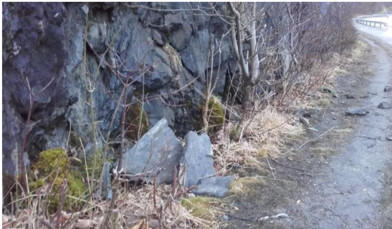
Større og mindre steinblokker rasar ned på gangvegen i Kleivadalen.
