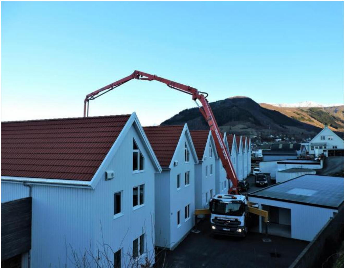
Betong frå Dimmelsvik Betong vart pumpa over husa og fram til skadeplassen.
