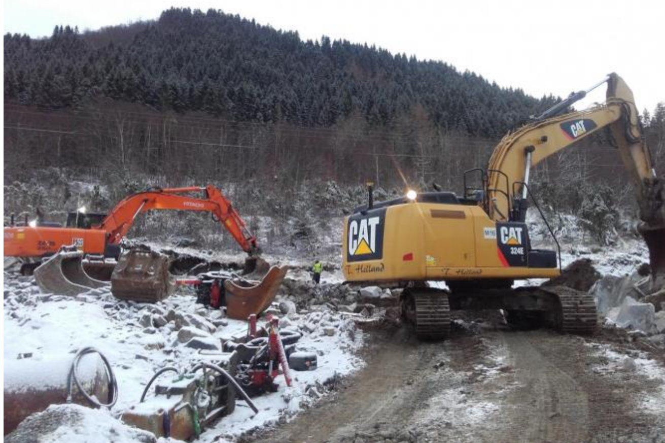
Tre maskinar er i arbeid med boring, sprenging og planering. Bilete er i svingen der det vil gå veg på ut og inn i feltet ( Sjå skissen under ).
