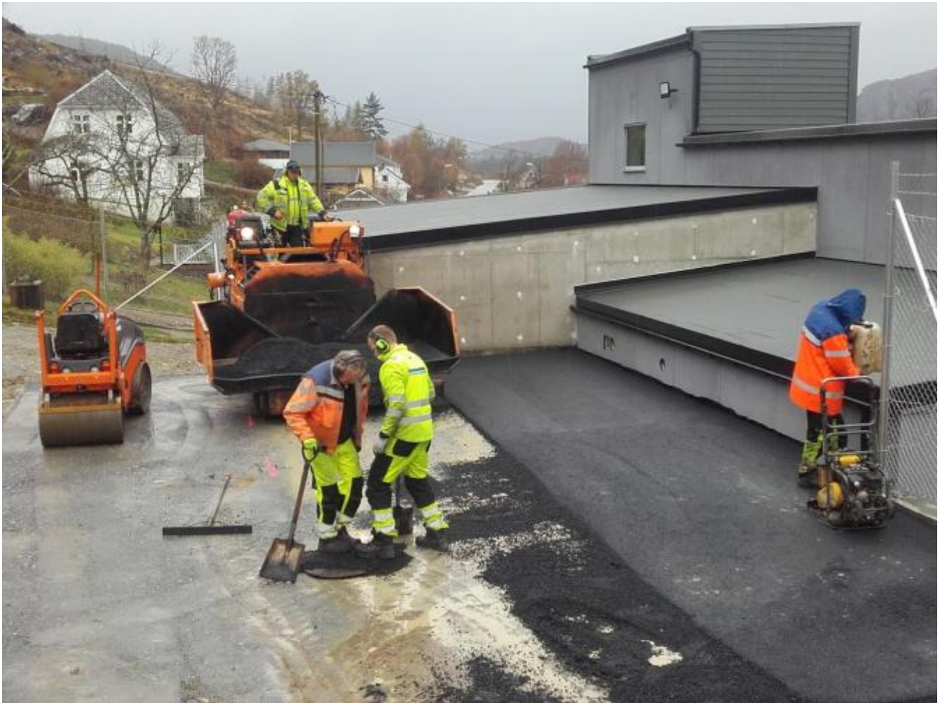
Arbeidet med oppgradering av Uskedal sekundærstasjon på Nedre Fet er inne i sluttfasen. Før helga vart alt utomhusareale asfaltert.
