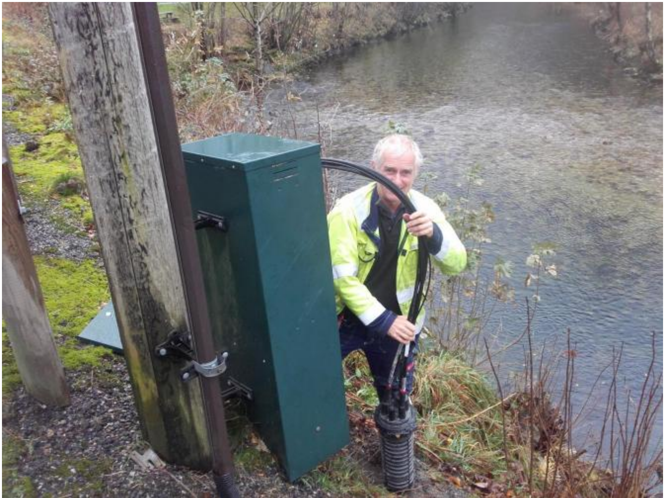
Gunnar Vaage ferdigstiller arbeidet ved Uskedal Bru, i det som vert kalla ein skøyt.
