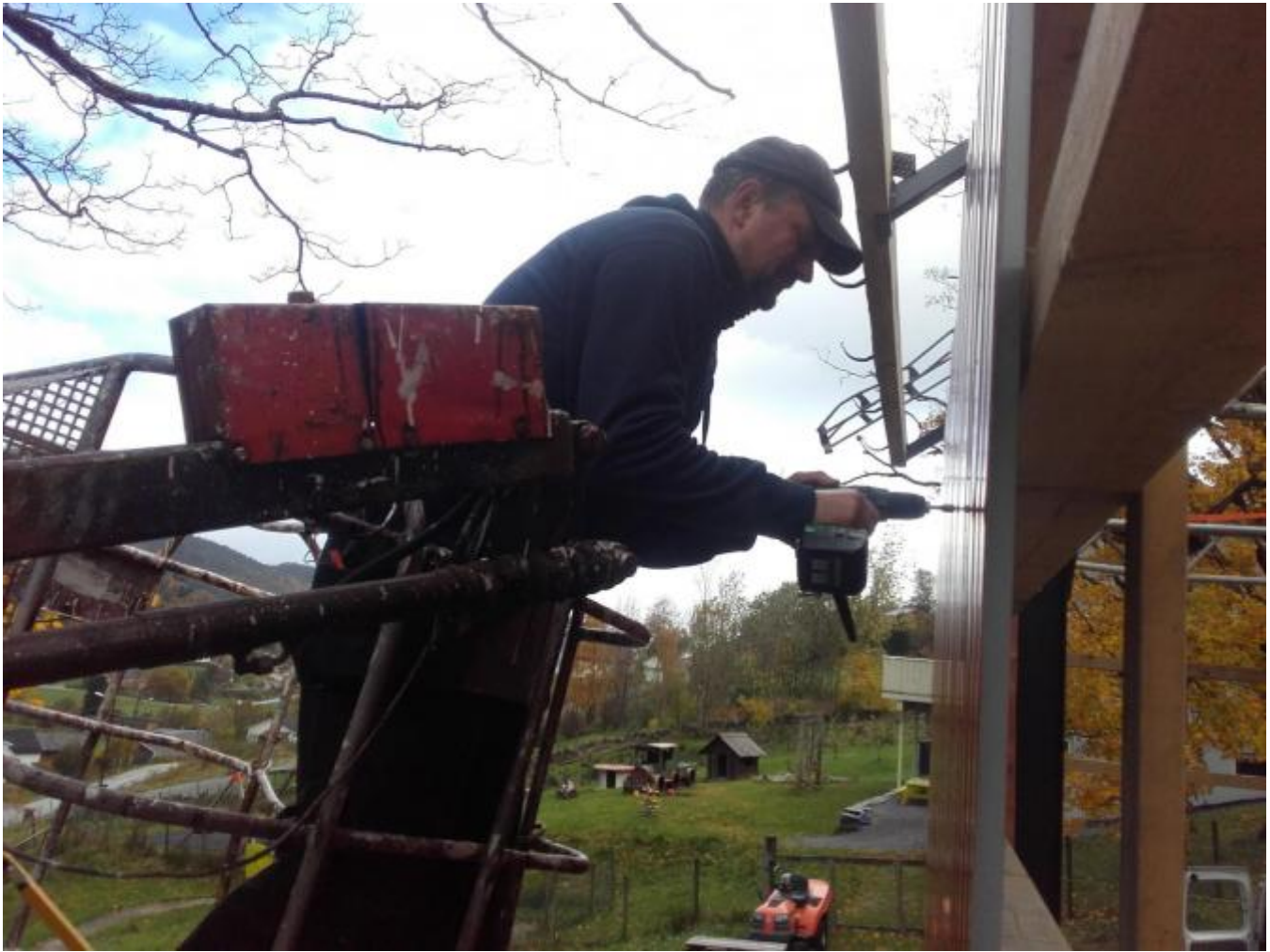
Erlend Bjørnebøle med god hjelp av far og svigerfar monterer vegg- og takplater.
