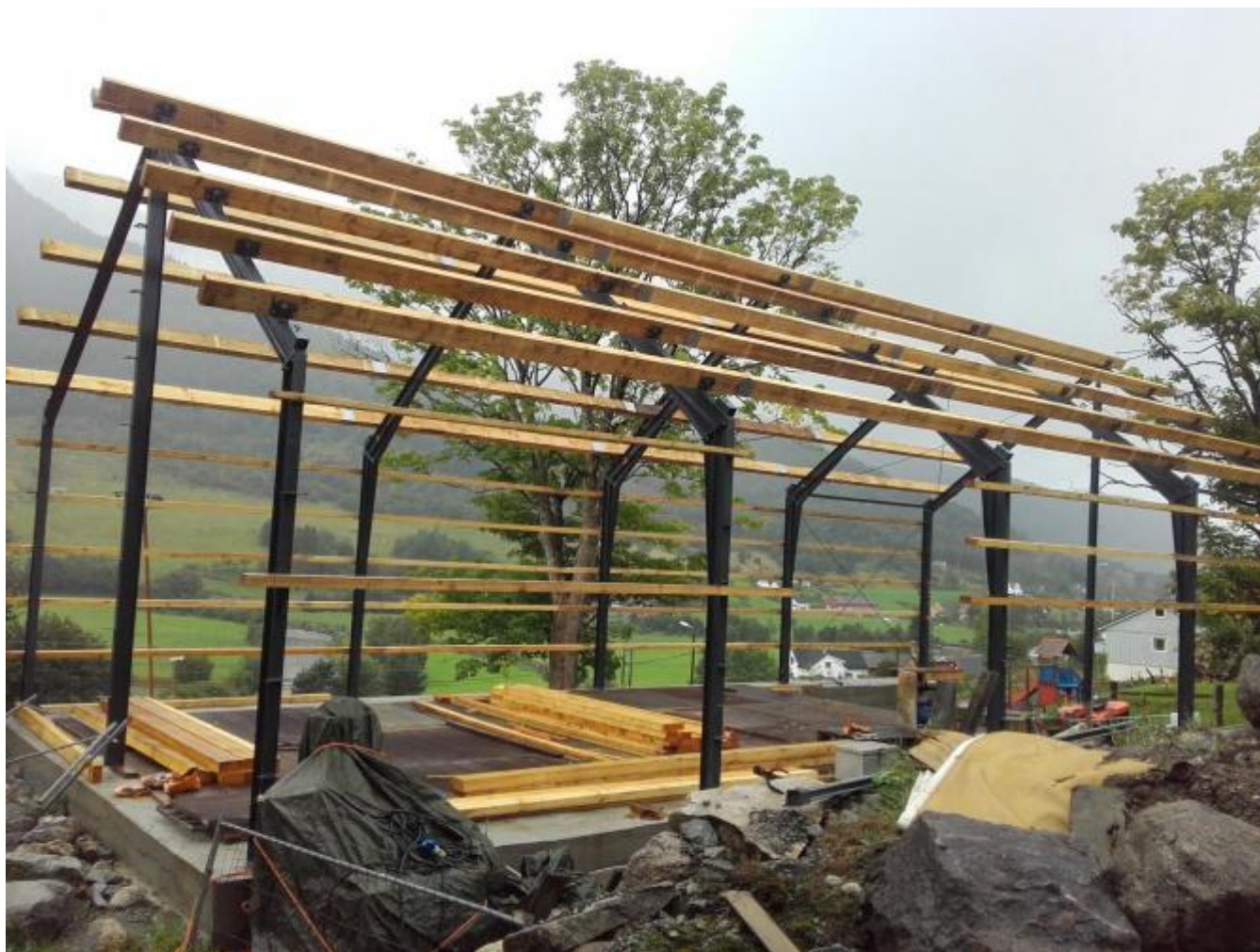
Reisverket er montert. Det neste i byggeprosessen er kledning og takplater.
