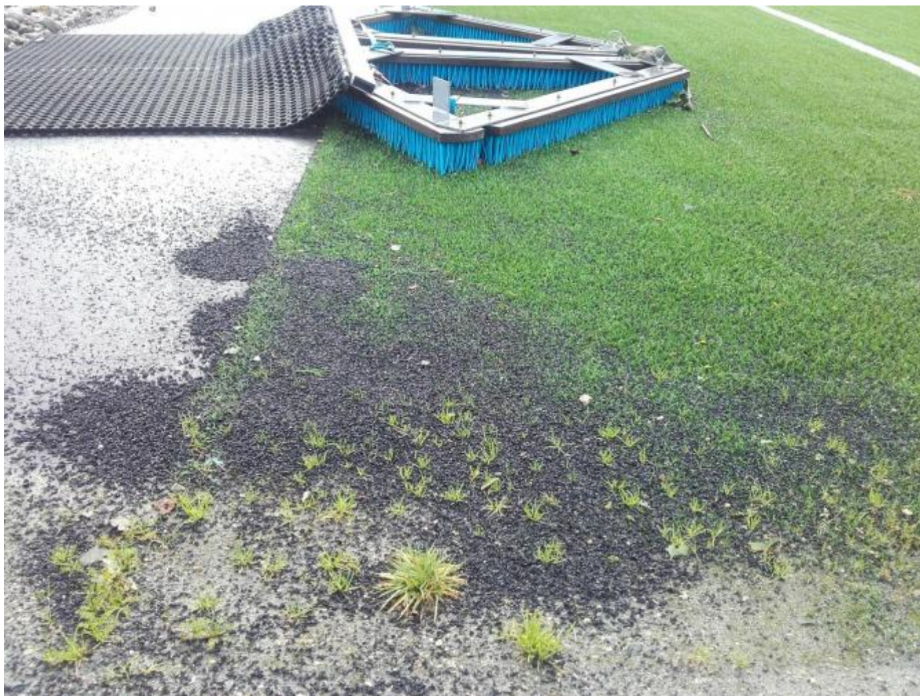
Eit av miljøkrava er å få montert sandfangkummar som samlar opp gummikulene.
