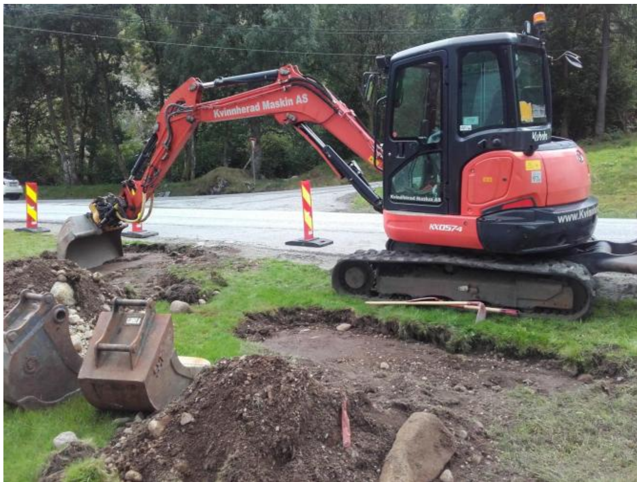
Vasslekkasjen på Eikelandet er utbetra og abonnentane har fått vatnet tilbake.
