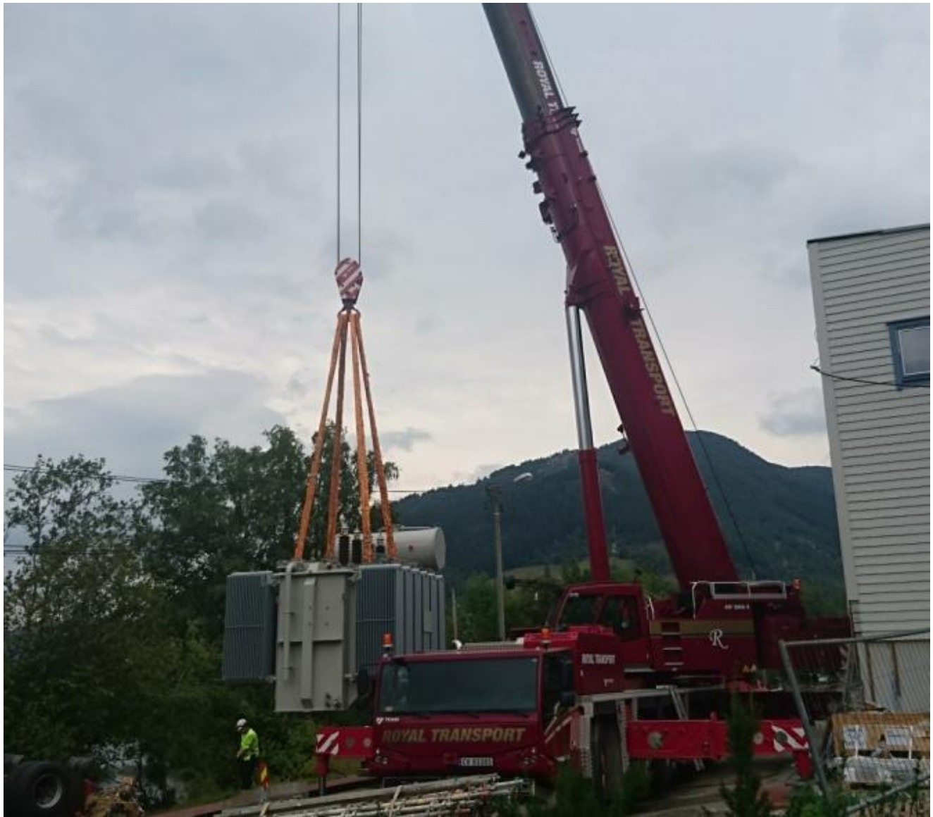
Her vert det gjort eit løft på 46 tonn av kranbil frå Royal Transport i Bergen.
