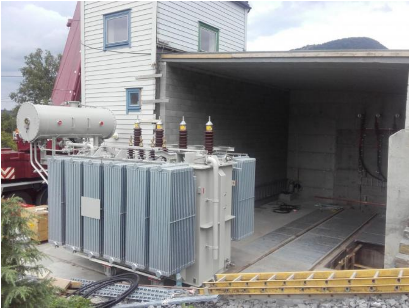
Den nye traoen er på plass og skal jekkast inn der den skal stå.
