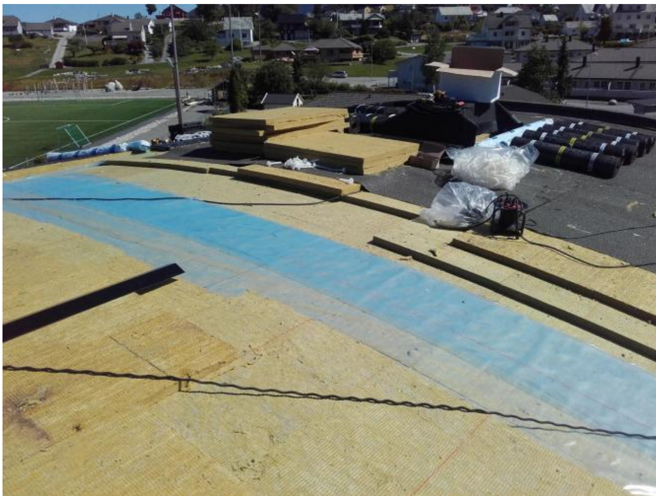
NY isolasjon og ny takpapp er på plass på Aktivitetshuset.
